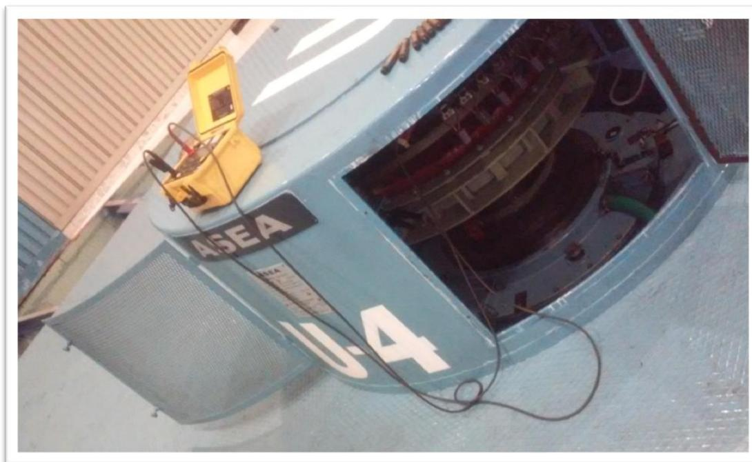
**FIG. C2** PRUEBA DE RESISTENCIA DE AISLAMIENTO AL CAMPO DEL GENERADOR
