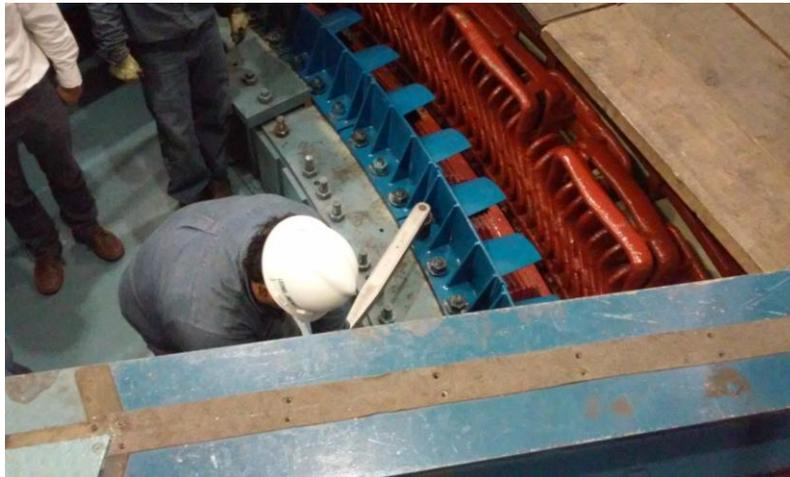
**Fig. 4.11** Torqueo de Aspas de Ventilación
