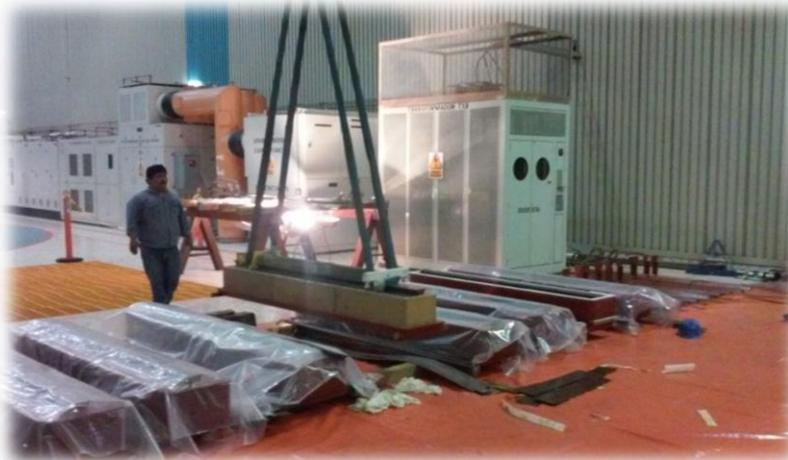
**Fig. 4.24** Colocación de núcleo, para unión con bobina.
