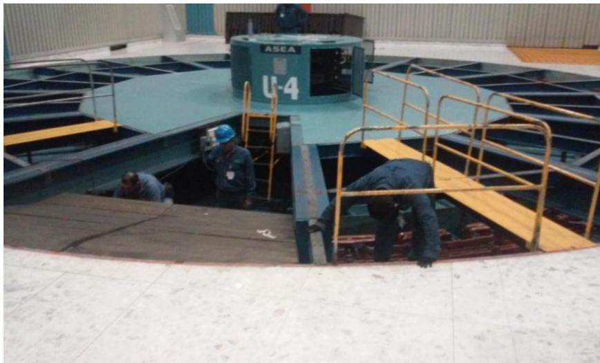
**Fig. 4.3** Desmontaje del Generador
