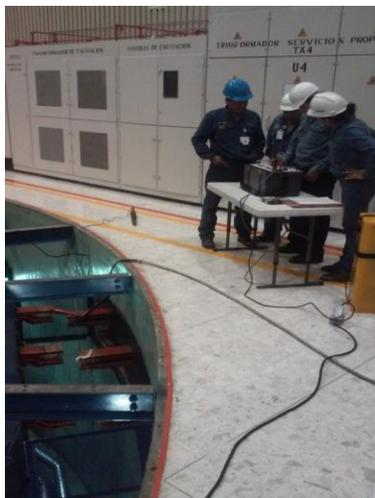
**Fig. 4.5** Prueba de Alta Tensión por Fase
