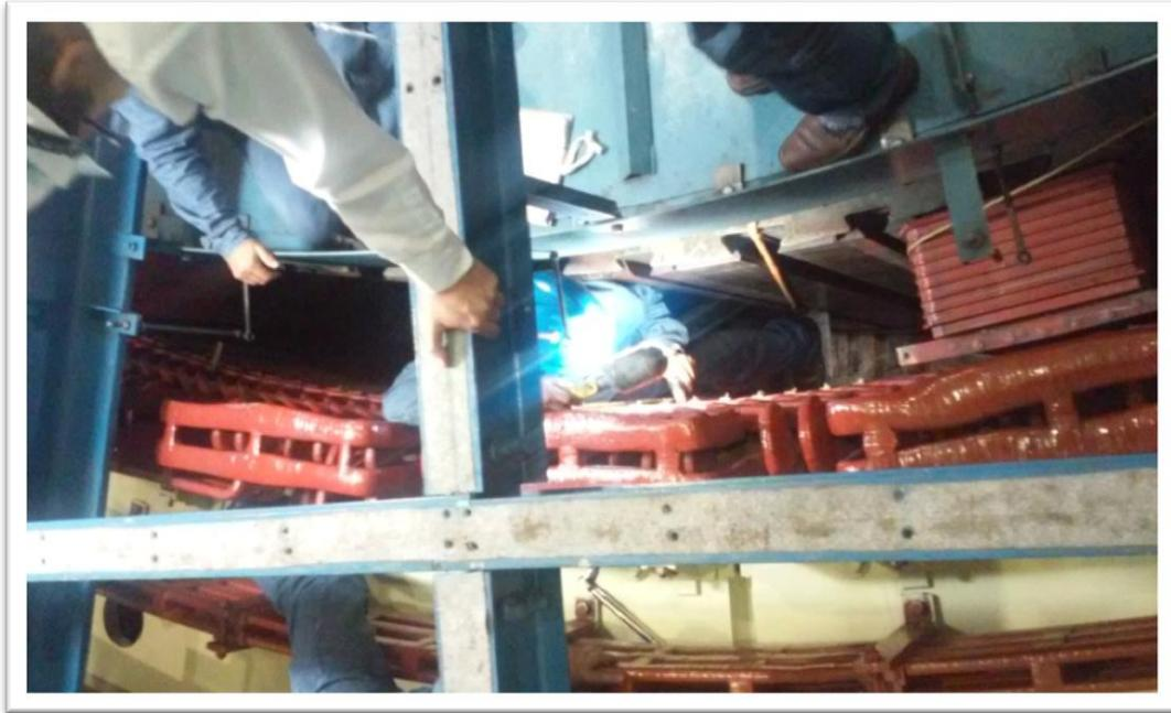
**FIG. C 13** REVISION DE LAMINADO, PUNTOS DE SOLDADURA EN DEDOS OPRESORES Y REVISION DE APRIETE DE DEDOS
