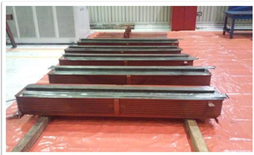
**FIG. C7** POLOS RETIRADOS A DAR MANTENIMIENTO
