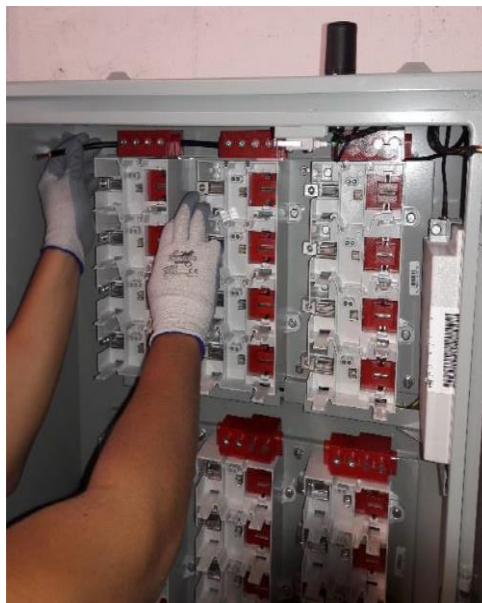
Figura 3.27. Desmontaje de Bus bar.
