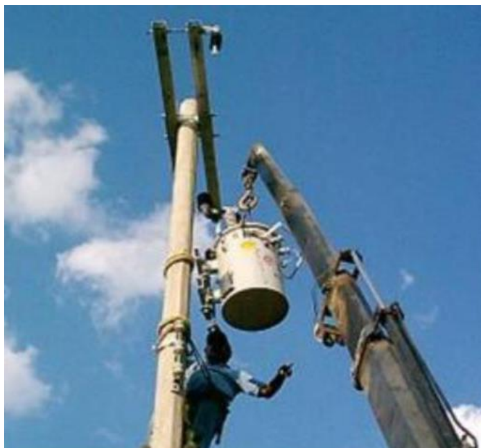
Figura 3.21. Montaje de Transformador.
