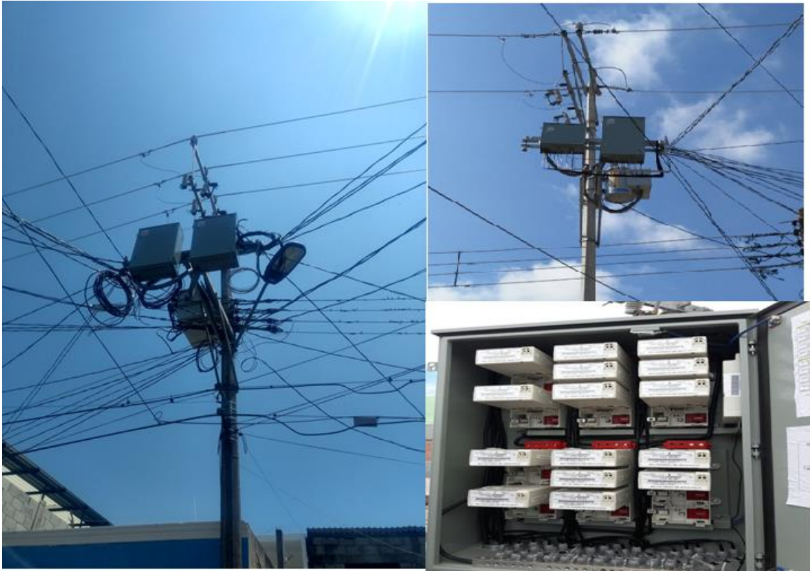
Figura 3.38. Instalación de acometida en gabinete.
