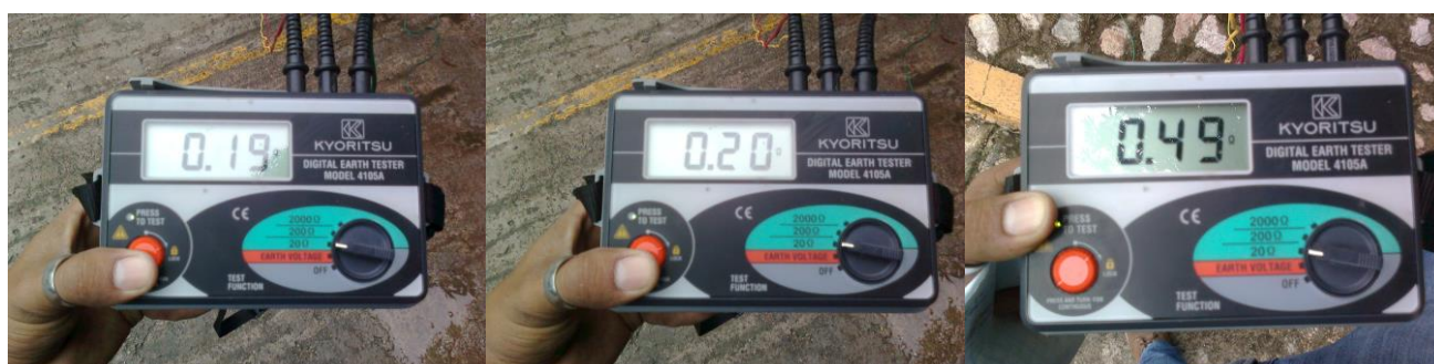
Remodelación de la subestación y sistema de tierra
