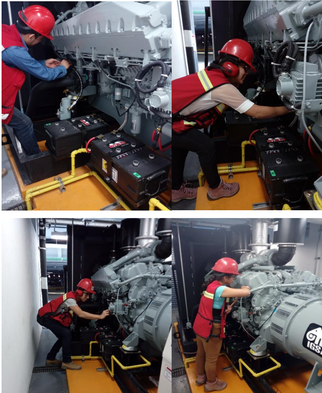
Fig.30 - Monitoreo, revisión, ajuste y limpieza del motor
