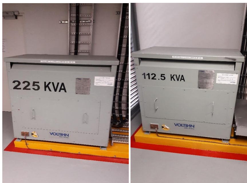
Fig. 45.- Transformadores secundarios
