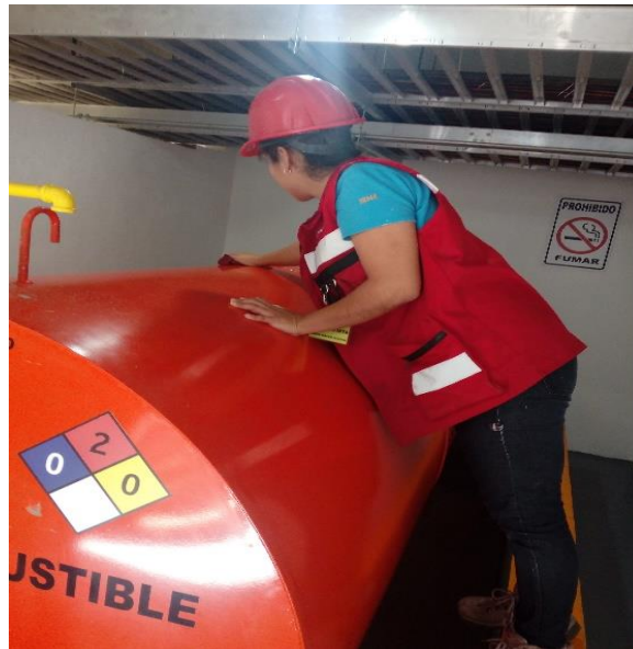
Fig. 31 - Limpieza exterior del tanque
