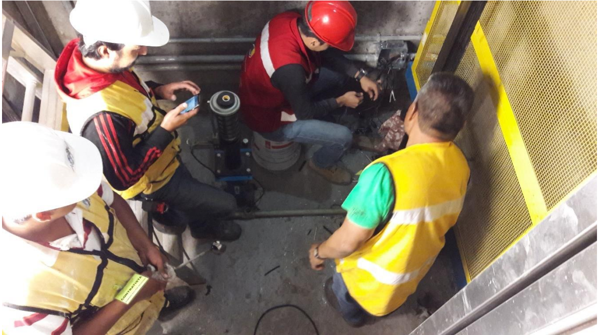
Fig.55 - Reemplazo de cable nuevo por falla de corto circuito
