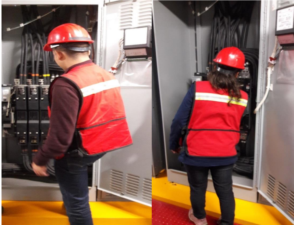
Fig. 53 - Verificación de cables
