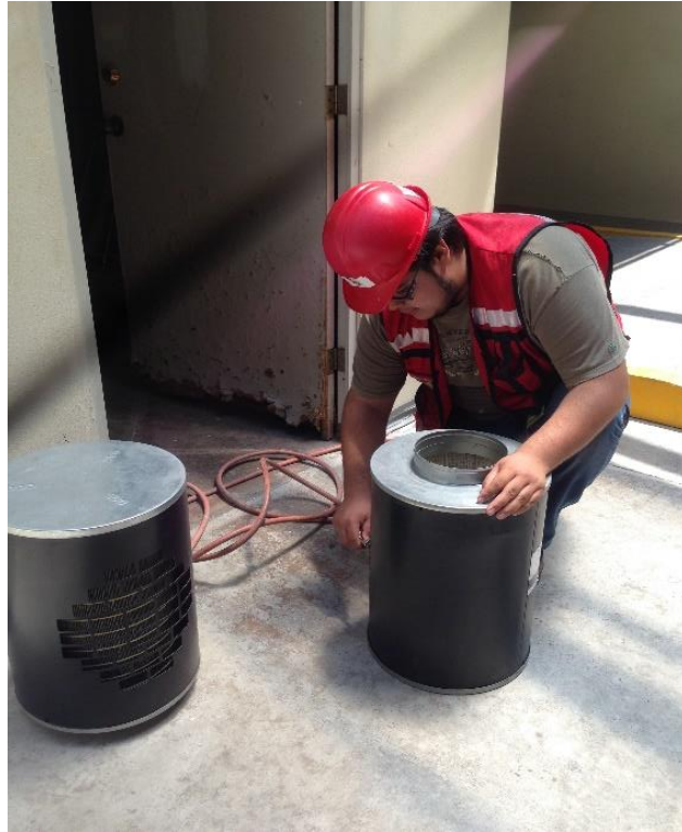
Fig.35 - Limpieza del filtro de aire
