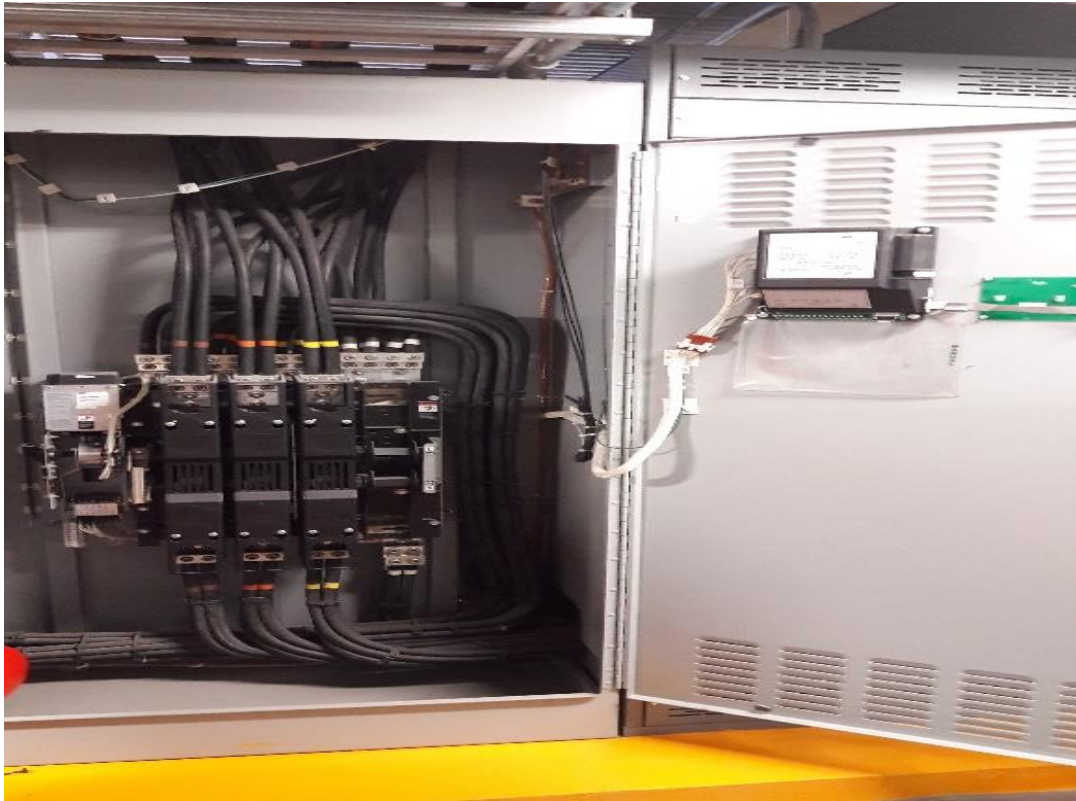
Fig. 41.- Interruptor de transferencia de potencia
