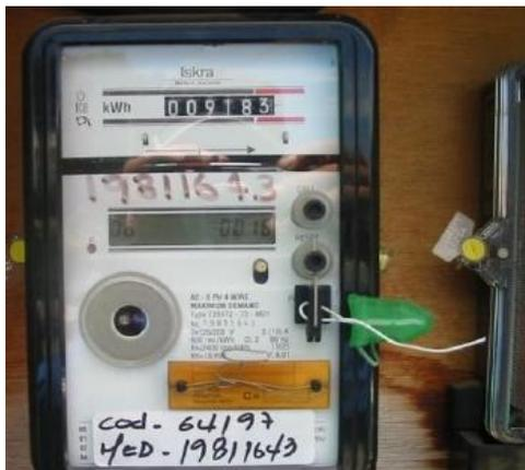
**Fig.2.2** Medidor electromecánico con pantalla electrónica.
