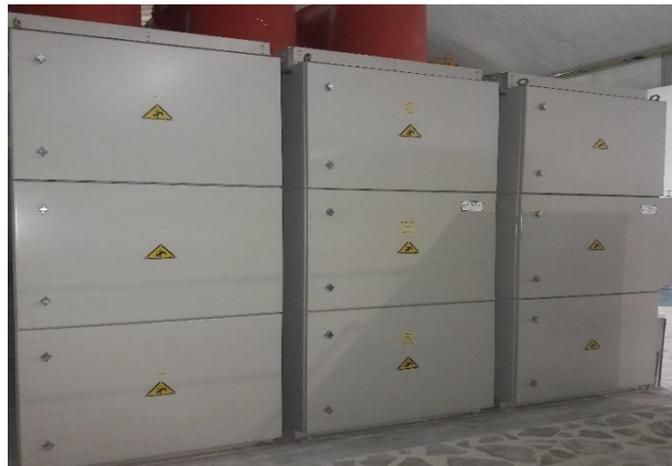
**Fig.3.17** Gabinete de los TP's de Medición, Protección y Regulación de la U-6.
