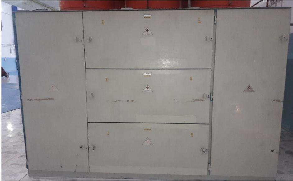
**Fig.3.12** Gabinete de los TP's de Medición, Protección y Regulación de la U-5.
