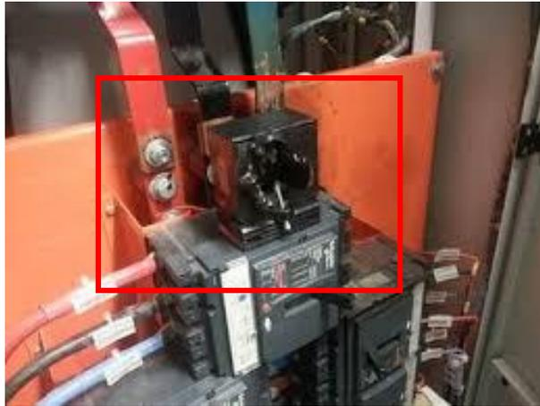
**Fig.2.9** *Ruptura de un TC.*
