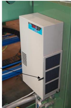
**Figura 5.6.- Aire acondicionado del sistema eléctrico.**
