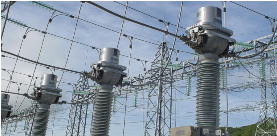
Figura 2.1.2.1 se observa un grupo de TC's de 115 KV en la SE Sabino.
