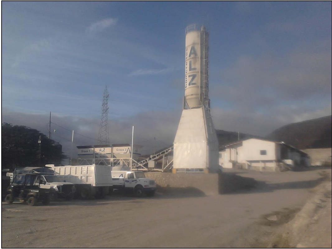
Fig. 4.2.- Planta Tuxtla, en esta planta se produce concreto premezclado y sin premezclar, así también, produce Carpeta Asfáltica.
