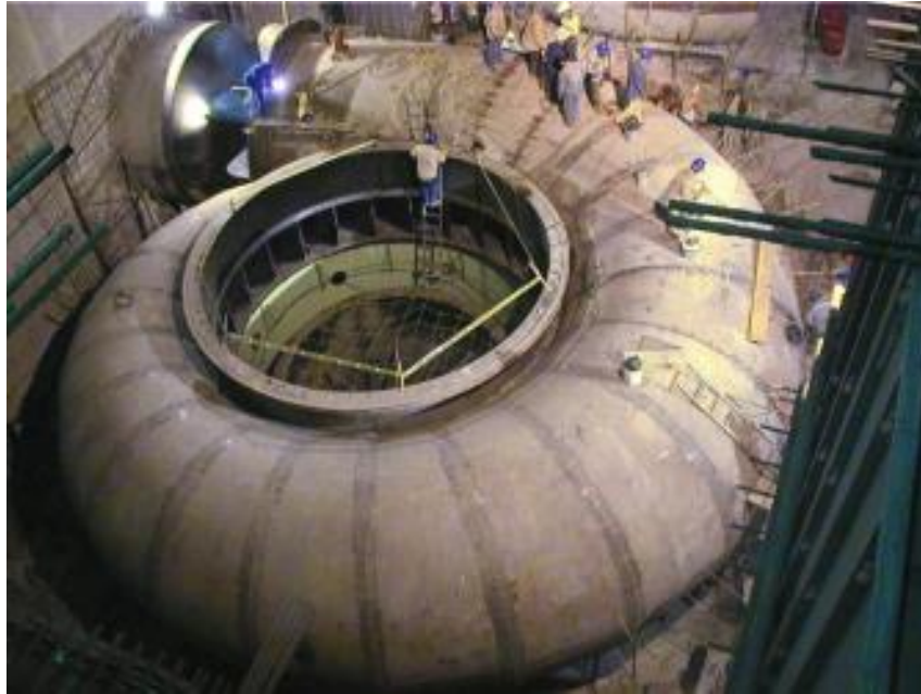
Imagen 2.1. Fotografía de una carcasa espiral.
