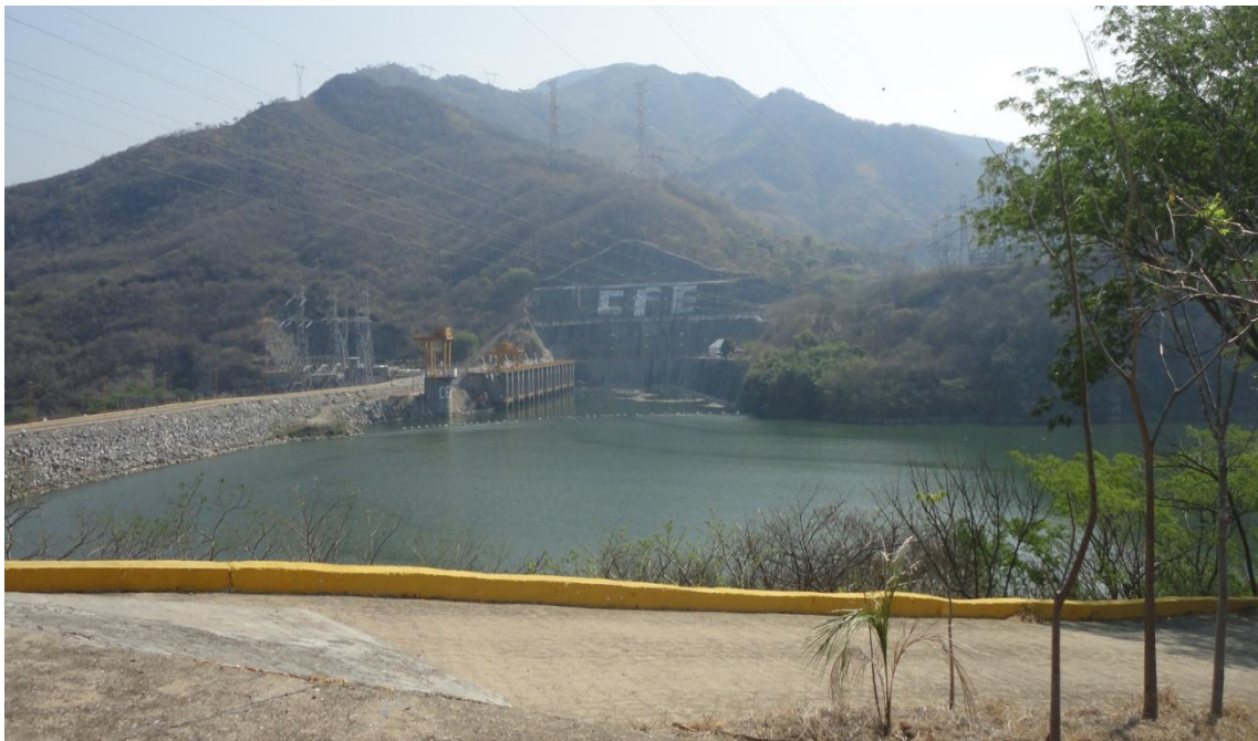
Imagen 1.1. Fotografía de la cortina de la Central Hidroeléctrica Manuel Moreno Torres.
