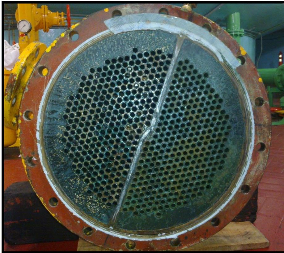
Fig. 3.4 Arreglo escalón o alternado del intercambiador de calor de la C.H. Belisario Domínguez.
