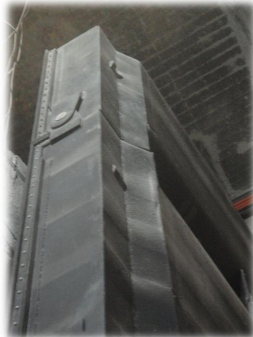
Fig 12. Sellos para compuertas, tipo nota musical. Ver anexos.
