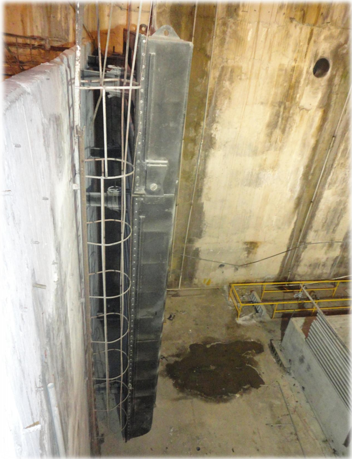
Fig. 27 Compuerta deslizante de desfogio, imagen recabada en campo.
