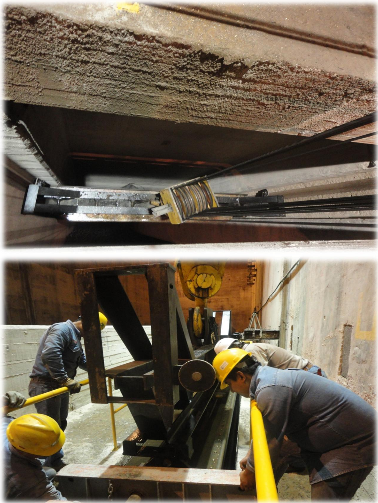
Fig. 29 Maniobra de izaje de la compuerta lisa deslizante de desfogue.
