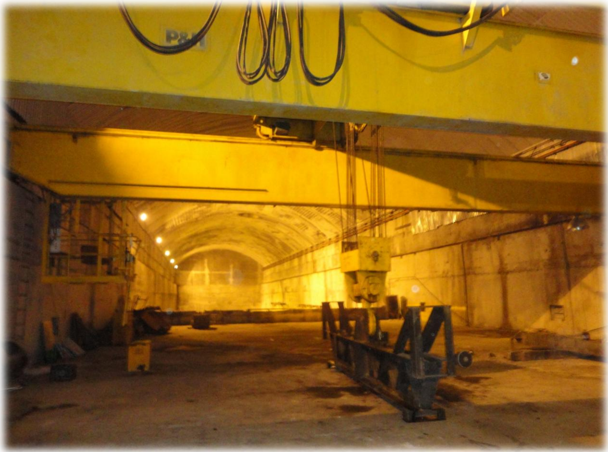
Fig. 28. Grúa de izaje y guía pescadora para las compuertas de desfogue de la C.H. Manuel Moreno Torres.
