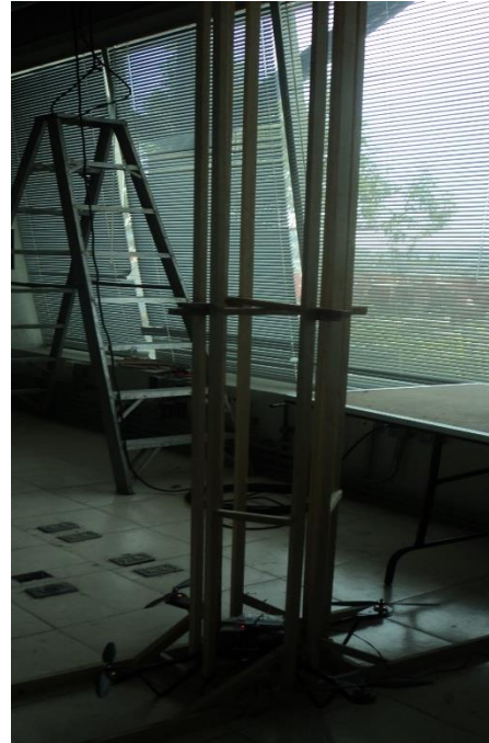
Figura [6.19]: Estructura hecha de madera
