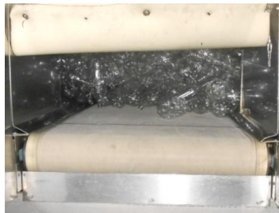
Fig. 39.- Imagen de la salida de los silos la cual nos muestra la obstrucción de las botellas.
