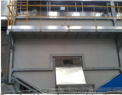
Fig. 9.- Vista frontal del silo de almacenamiento 1.
