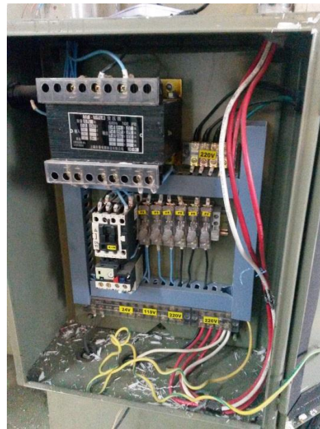
Inspección de cableado eléctrico y fusibles
