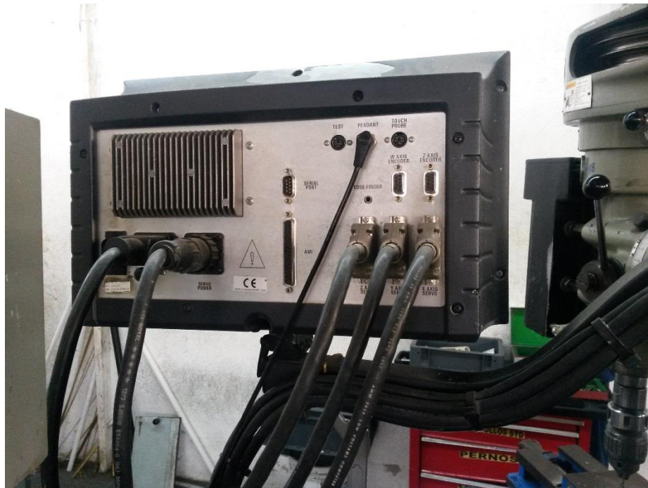
Revisión de cableado de los servomotores
