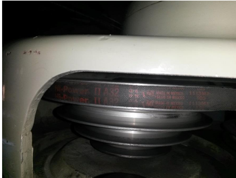
Verificación de la correa y tensión de la misma.
