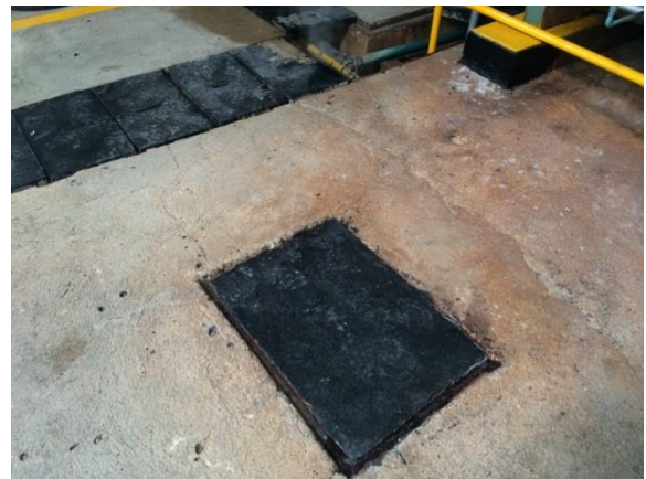
Figura 1.4 Cisterna de condensados (donde se almacenan las purgas de la caldera)
