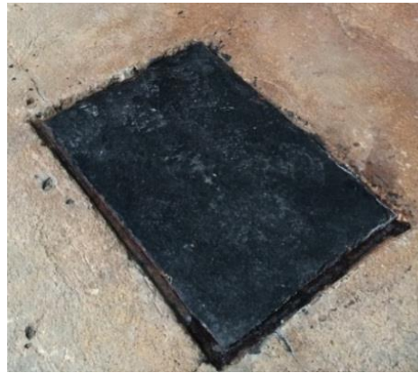
Figura 2.7 Depósito de retención de purgas
