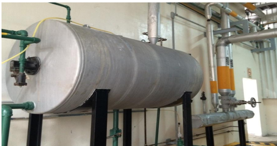
Figura 2.4 Estanque de alimentación y desaireador
