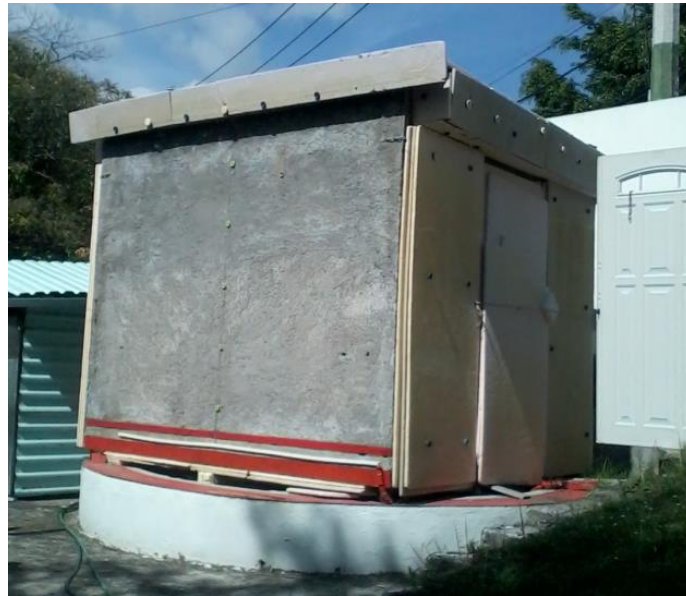
Figura 3.3. Fotografía de la caseta CAGETEV con aislamiento exterior
