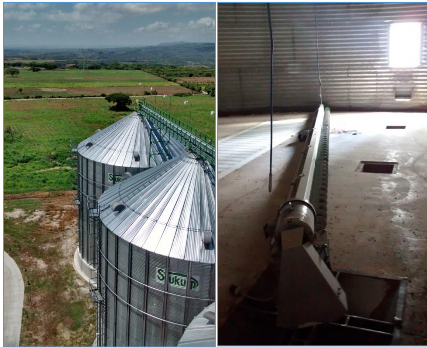
Figura 4.4.- Silo vista externa y silo vista interna; área: recepción y almacenaje.
