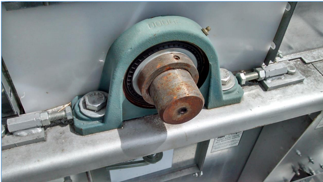
Figura 4.7.- Chumacera de piso de elevador principal.
