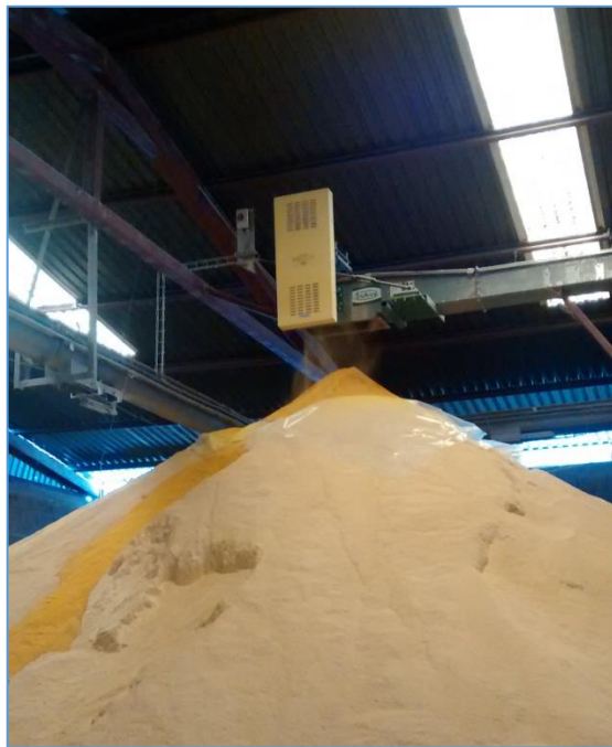
Figura 4.2.- Transportador aéreo depositando materia prima; área: Almacén Granel.
