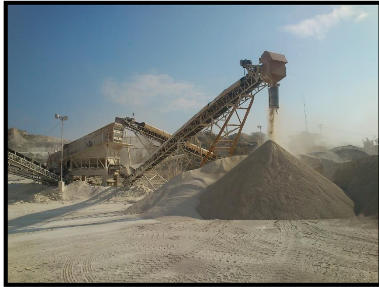
Fig. 3.8. Banda transportadora de arena en Planta 1.
