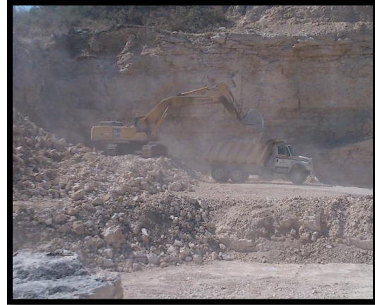
Fig. 3.3. Excavadora cargando un camión.
