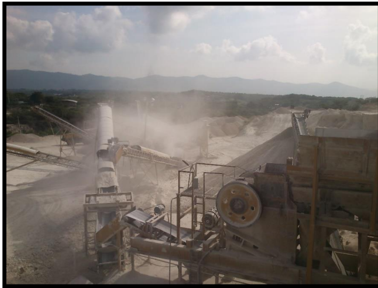
Fig. 2.5. Contaminación producida por Planta 1.
