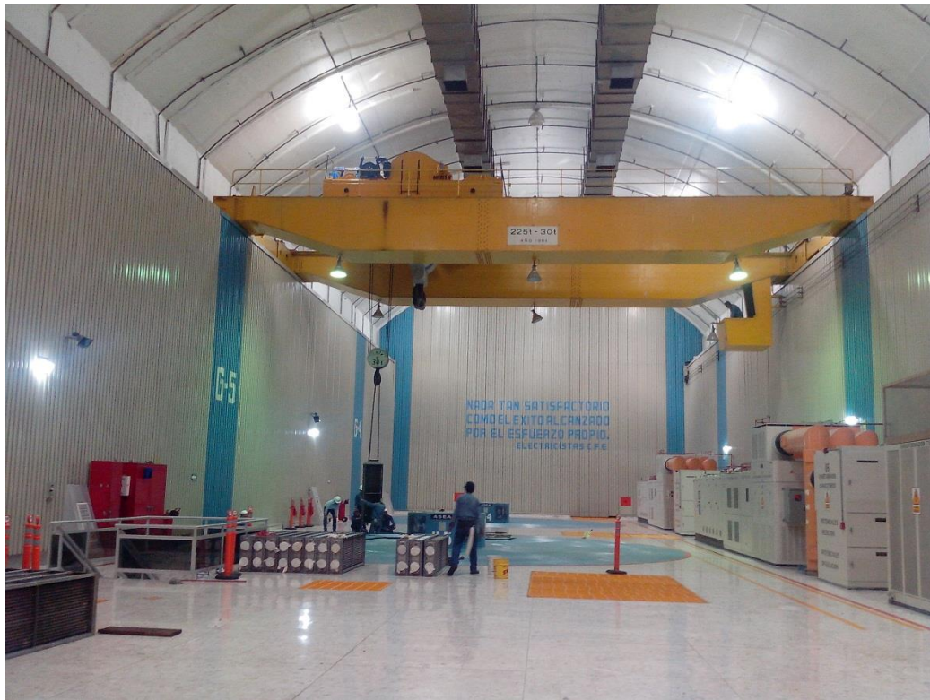
Figura 10.- Casa de máquinas 2ª etapa
