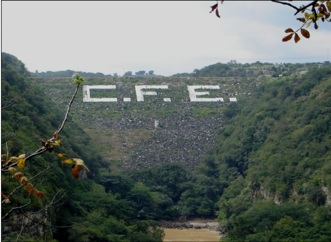
Figura 5.- La cortina de Angostura, actualmente es parte de la carretera de Tuxtla Gutiérrez a la población de Venustiano Carranza y las zonas cañeras del altiplano chiapaneco.
