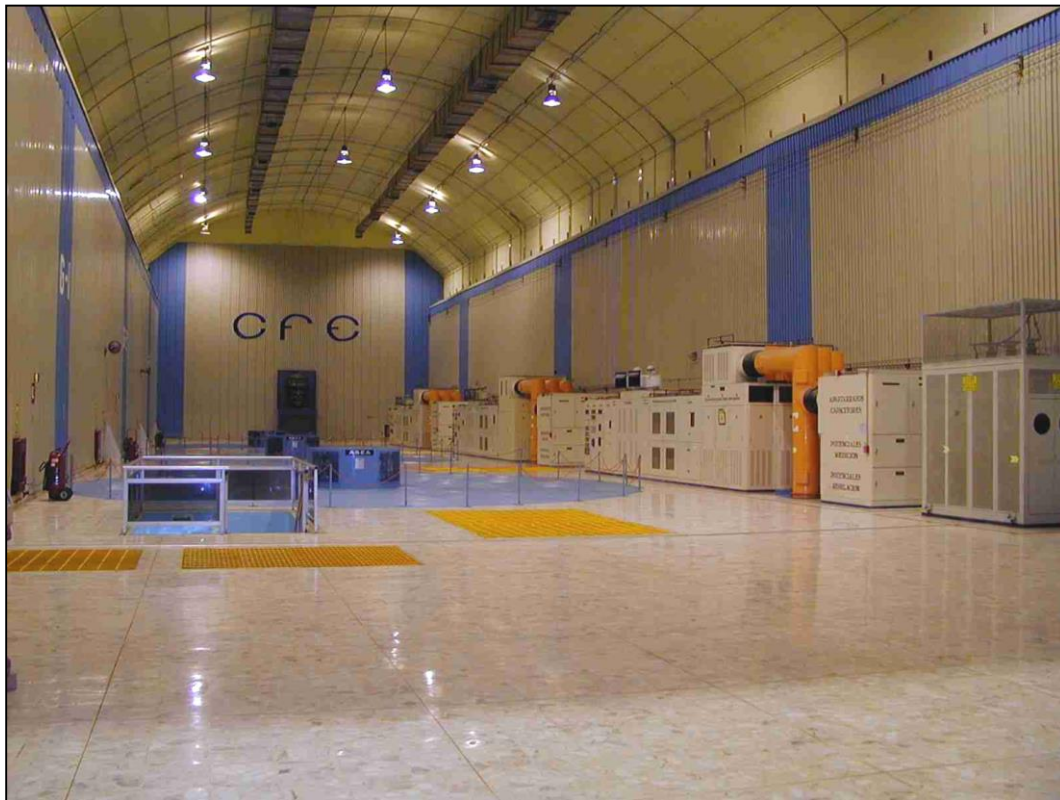
Figura 9.- Casa de máquinas 1ª. Etapa
