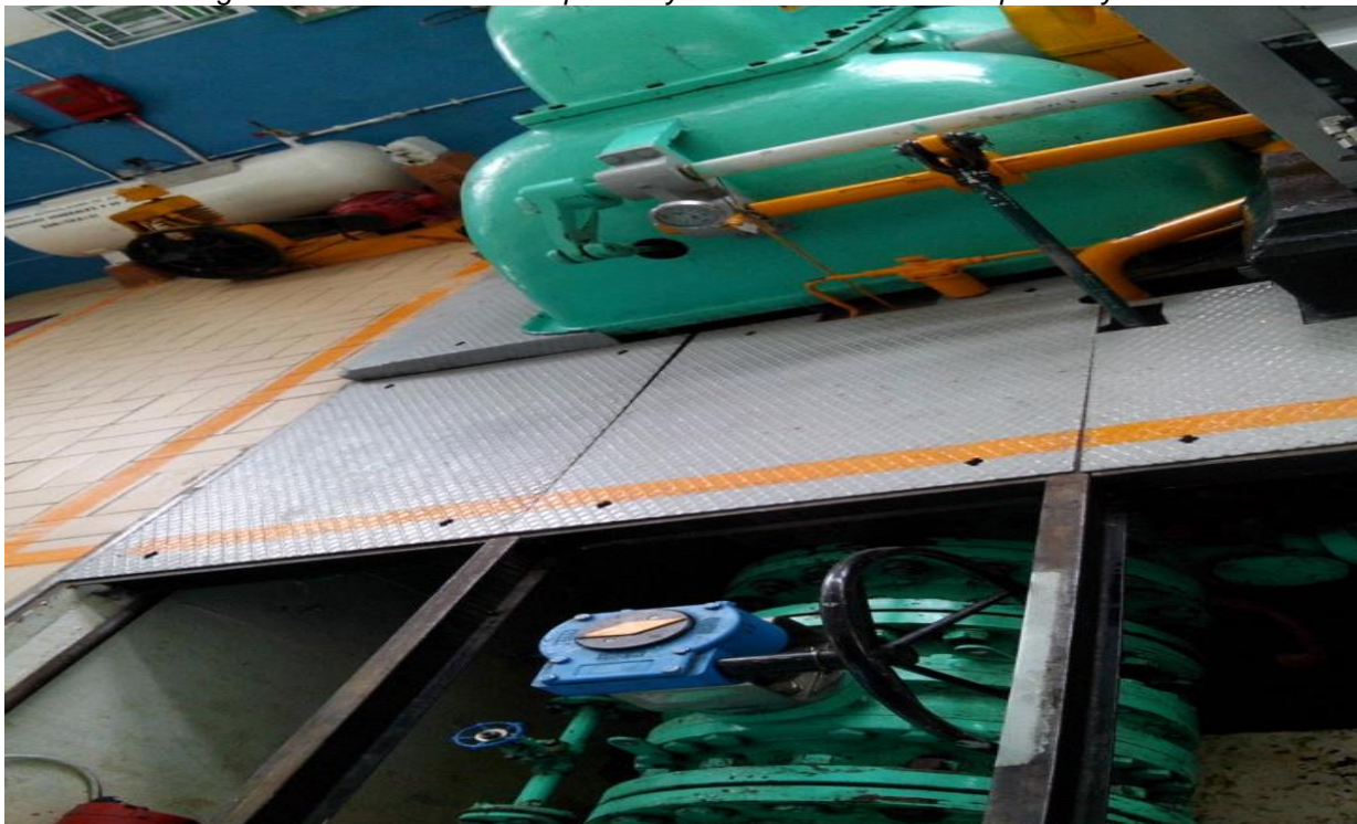
Fotografía 3.5.- barra de apertura y cierre del deflector y aguja.
