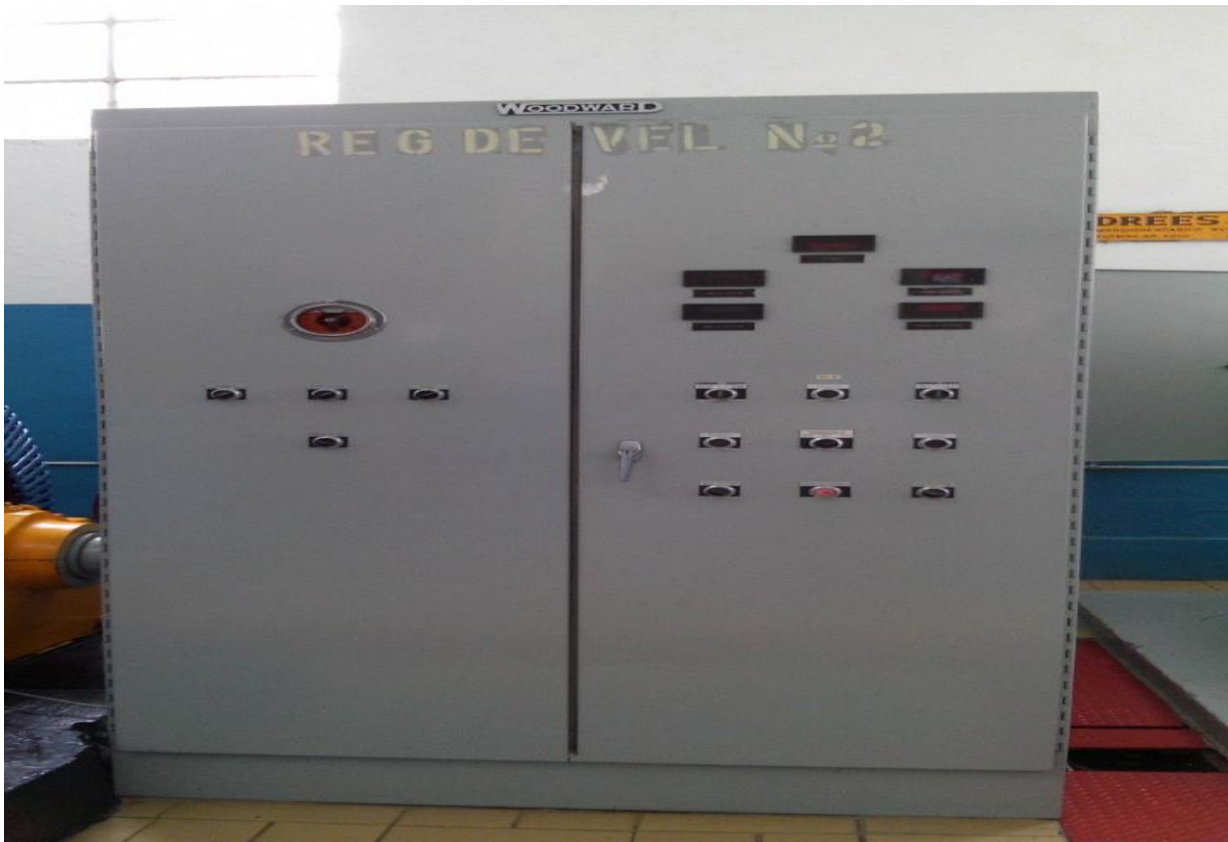
Fotografía 3.6.- Regulador de velocidad de la unidad no. 2
