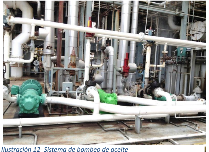
Ilustración 12- Sistema de bombeo de aceite
