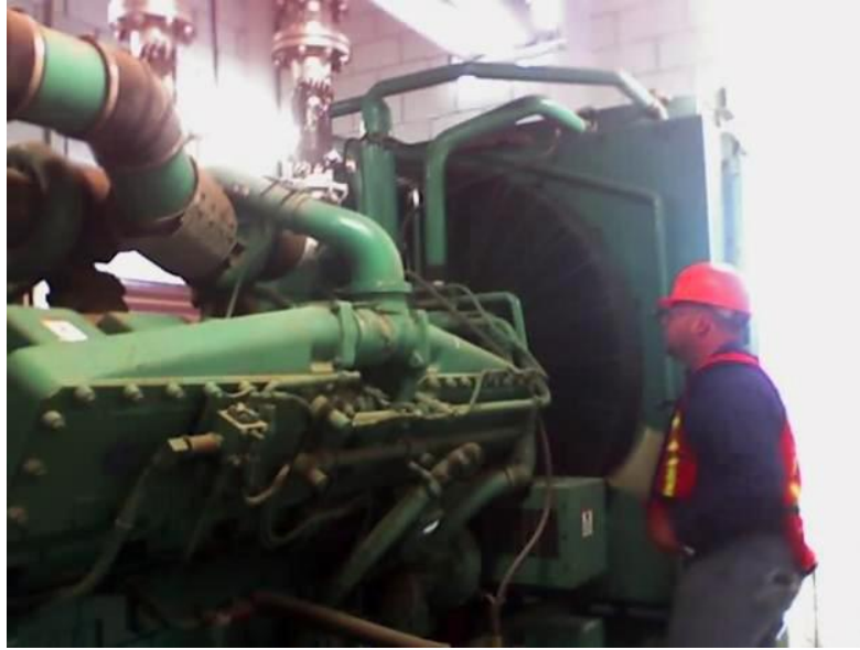
Fig. N° 3. Personal de mantenimiento predictivo tomando lecturas.
