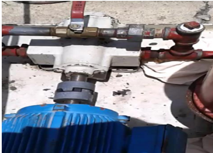
Figura 3. 14 Reemplazo de acoplamiento y limpieza de engranes
