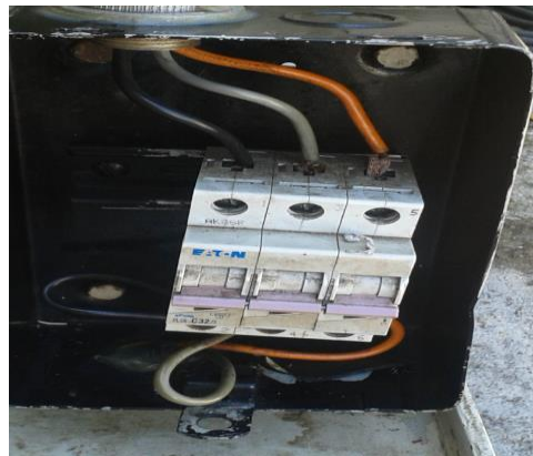
Figura 3. 15 Interruptor en buen estado
