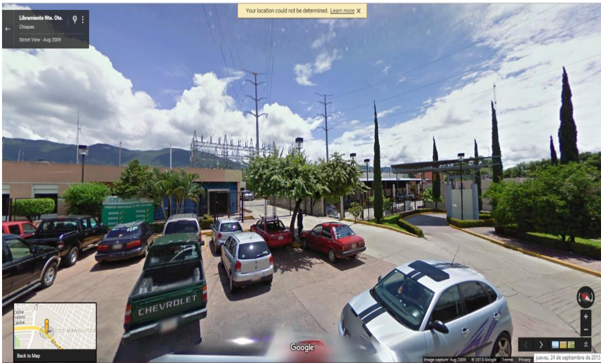
Figura 1. 2 Estación de comisión federal de electricidad
