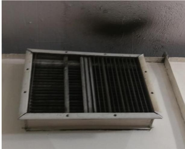
Figura 2 Escotilla de ventilación de los ductos.
