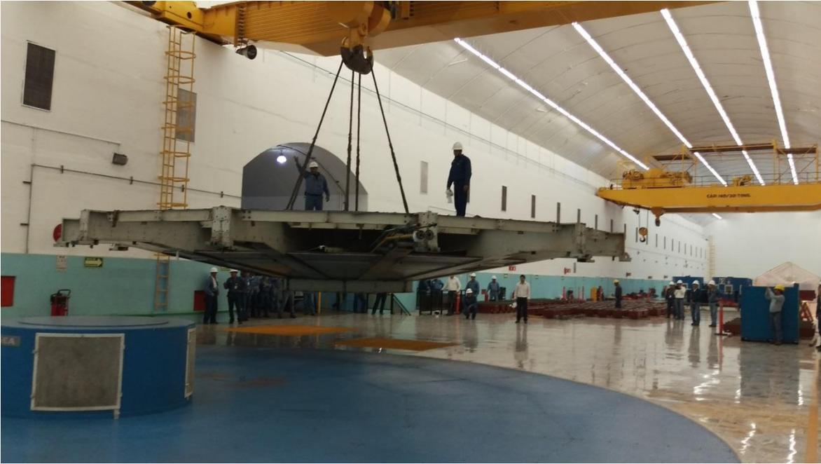
Figura 47 Desmantelamiento de araña del generador en manto.
