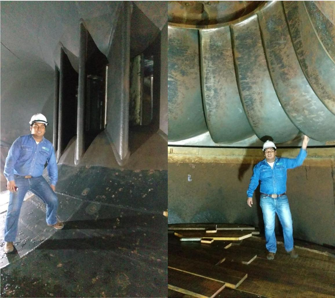
Figura 44 Caracol de tubería de presión y rodete de U-4.
