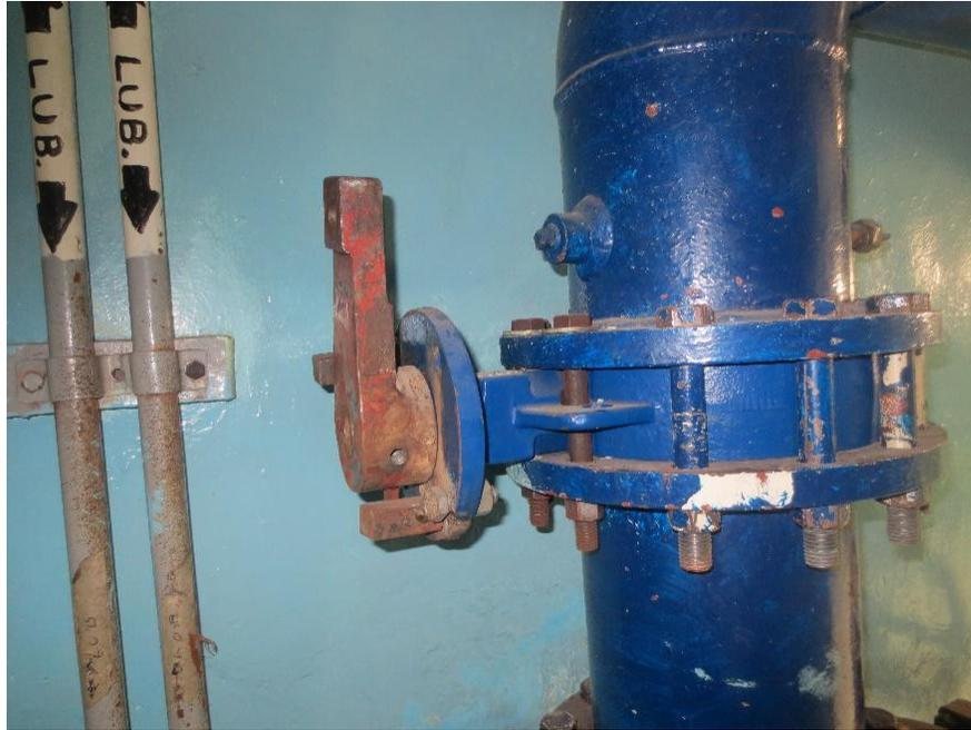
*Fig. 2.2 Mecanismo de apertura y cierre de la válvula.*
