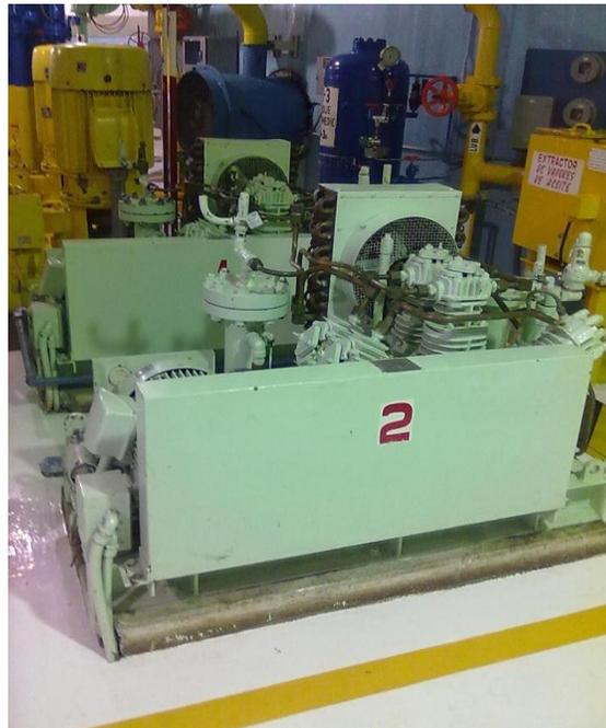
Fig. 4.2 Fotografía del compresor del sistema neumático usado para el circuito de gatos de frenado.
