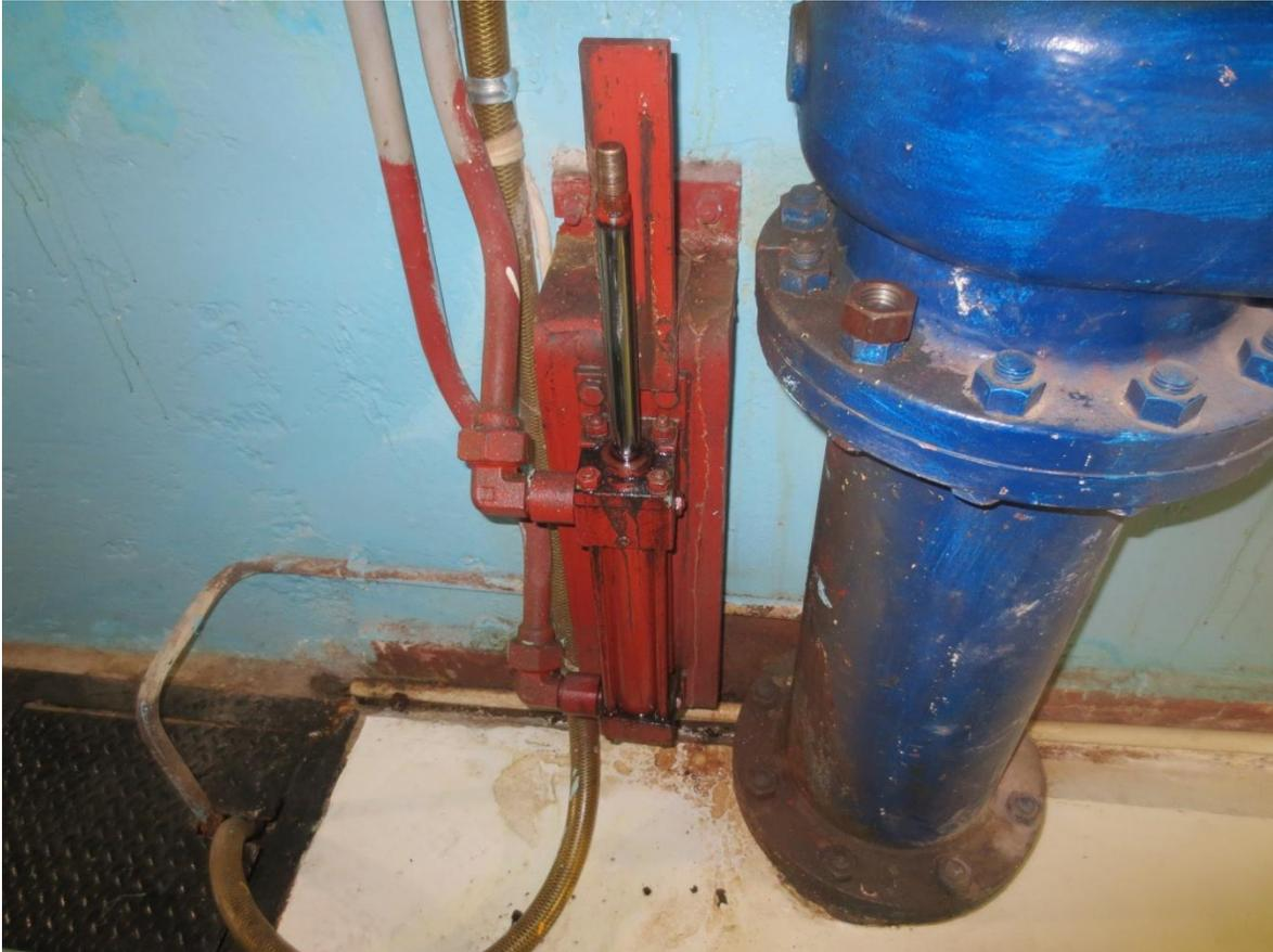
*Fig. 4.1 Fotografía del actuador hidráulico que acciona el mecanismo actual.*
