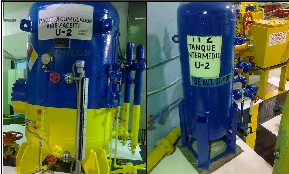
*Fig. 4.3 Fotografía del acumulador de aire-aceite y tanque intermedio de la CHMMT.*
