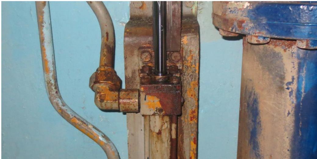
*Fig. 2.1 Cilindro hidráulico utilizado en la apertura y cierre de la válvula de aereación.*
