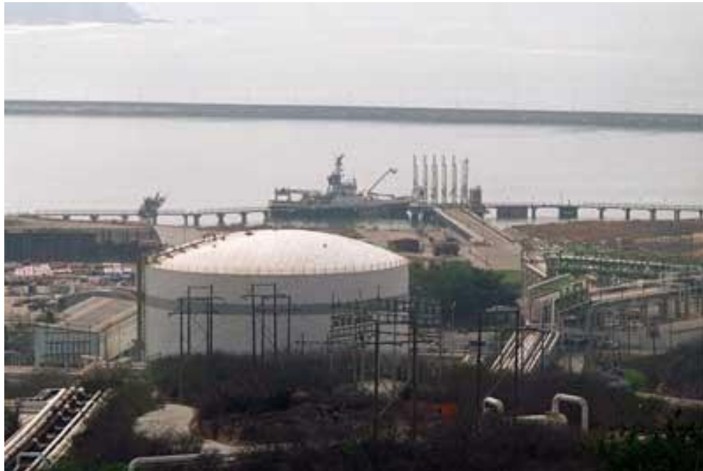
Fig. 1.1 Imagen de la planta BICA de la terminal refrigerada de distribución de amoníaco Salina Cruz.
