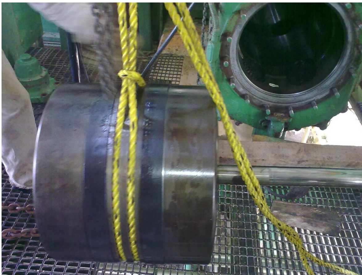
Fig. 37 Pistón desmontado del cilindro del compresor.
