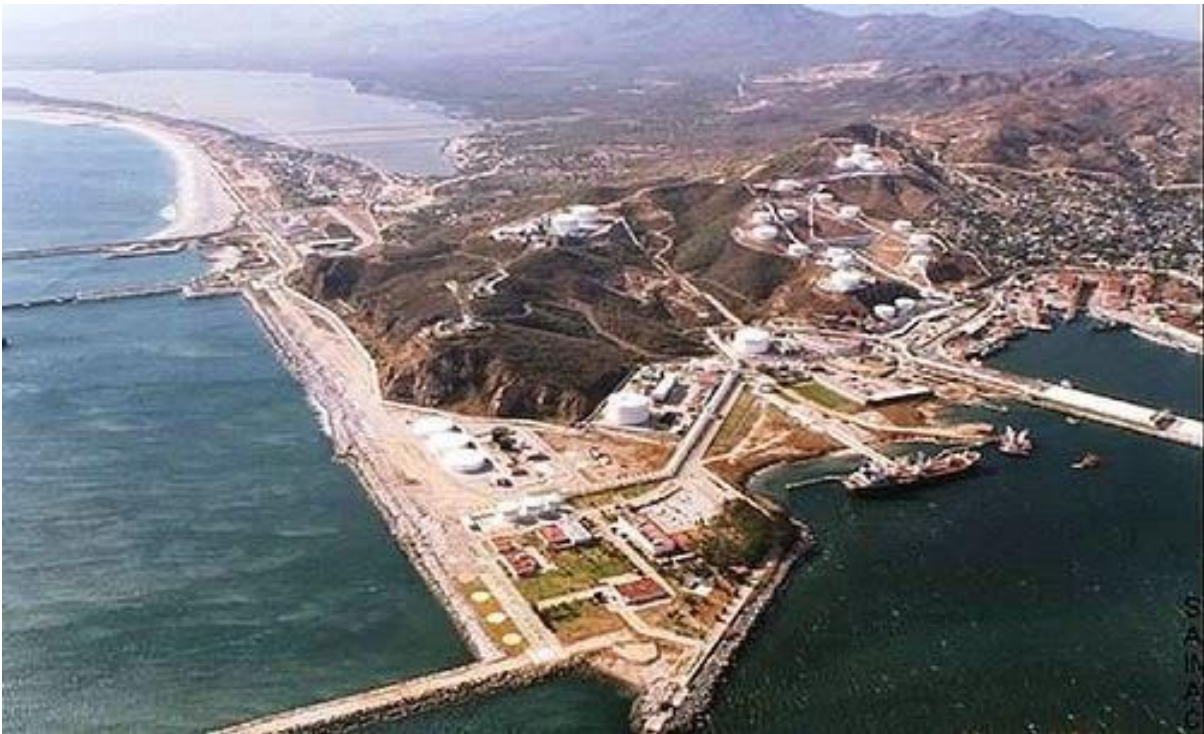
Fig. 1.3. Planta BICYQ y BICA de la terminal refrigerada de distribución de amoníaco Salina Cruz.
