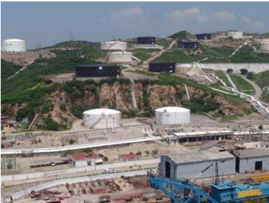
Fig. 1.2. Tanques de almacenamiento de amoniaco de terminal refrigerada Salina Cruz.
