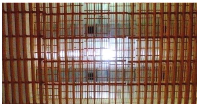
**Figura 4.20 – Arreglo de rejillas tipo Irving visto desde piso de turbinas de la C.H Belisario Domínguez.**
