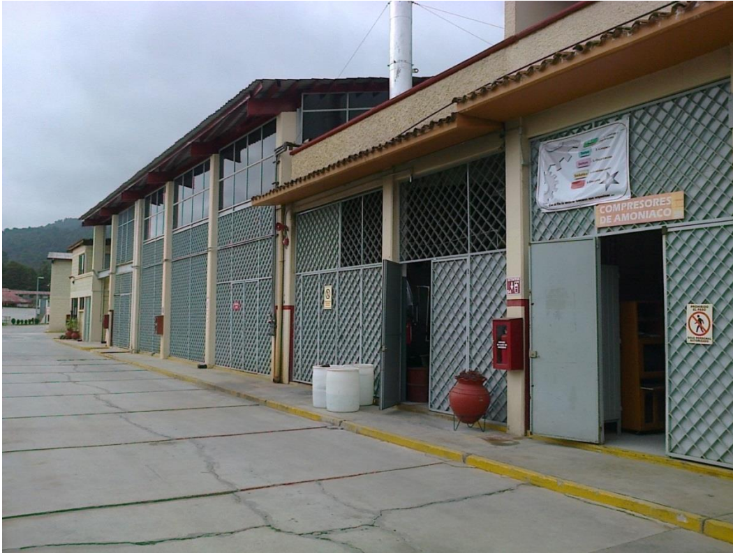
Figura 3-1 Área de servicios auxiliares
