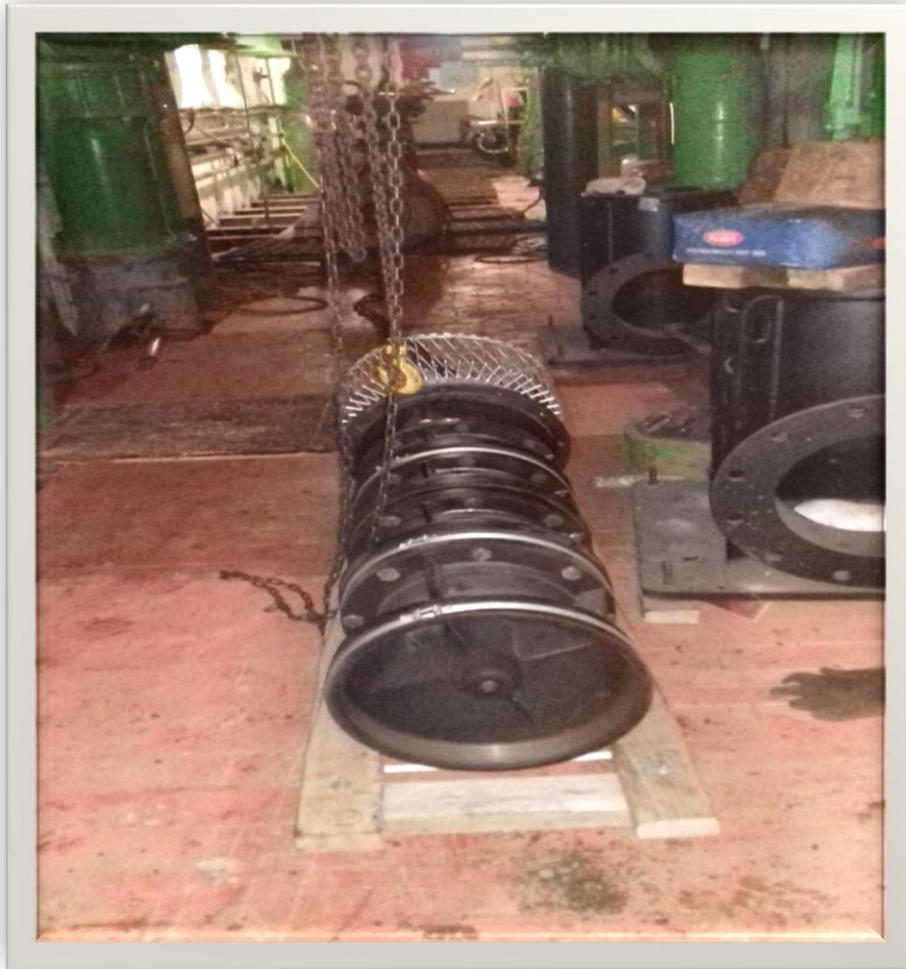
Figura 31. Bomba y cabezal en el área, preparándose para su instalación
