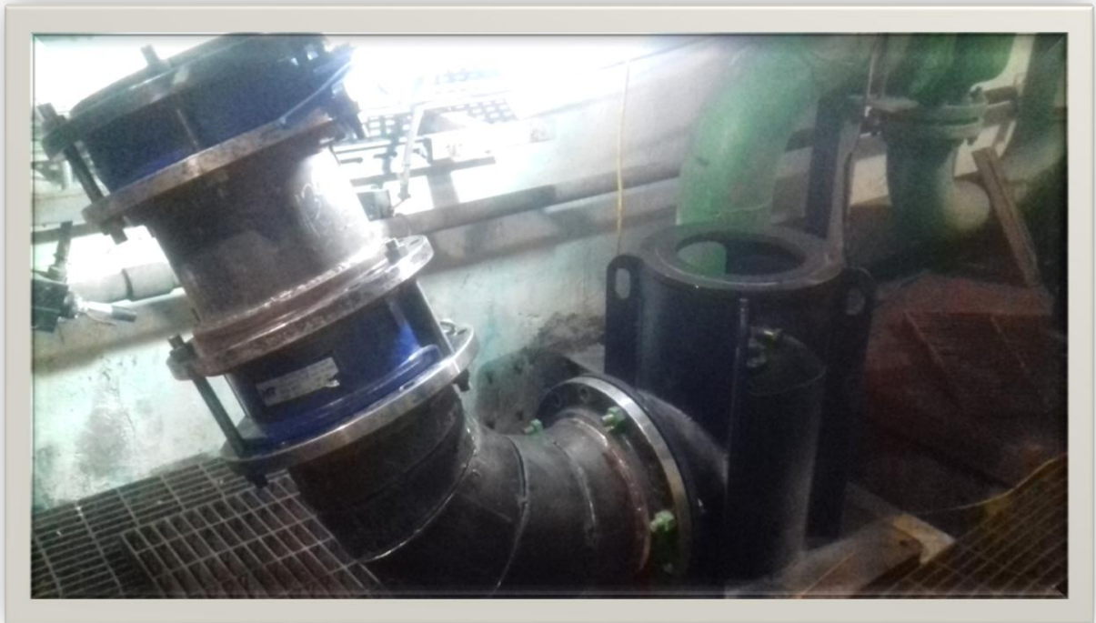
Figura 33. Cabezal y tubería de descarga instalados.
