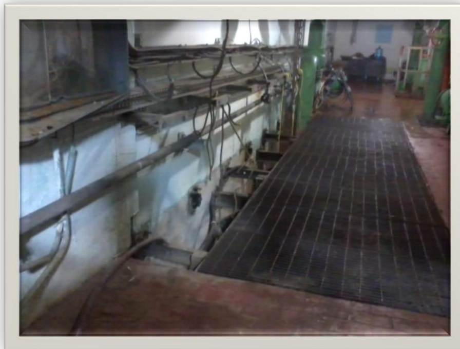
Figura 28. Desmantelamiento de cables
