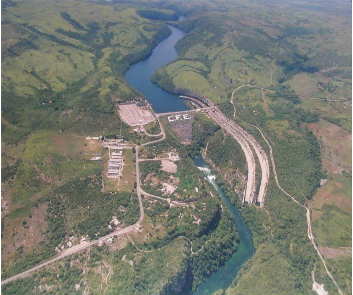
Figura 4.-Vista aérea de la Central.
