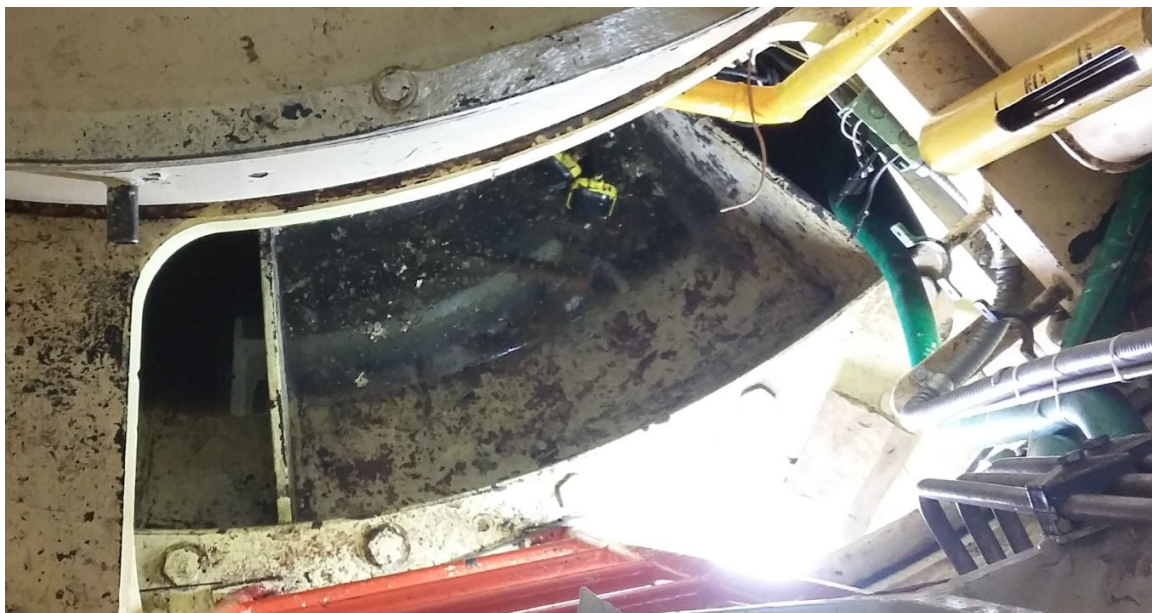
Figura 6.-Excedencia en los cubiculos del estopero.
