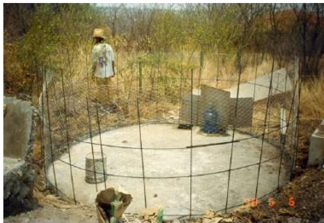
Figura 3.11 Tanque de ferrocemento superficial.
