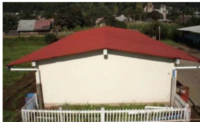
Fig. 3.1 Techo de escuela utilizado como área de captación.
