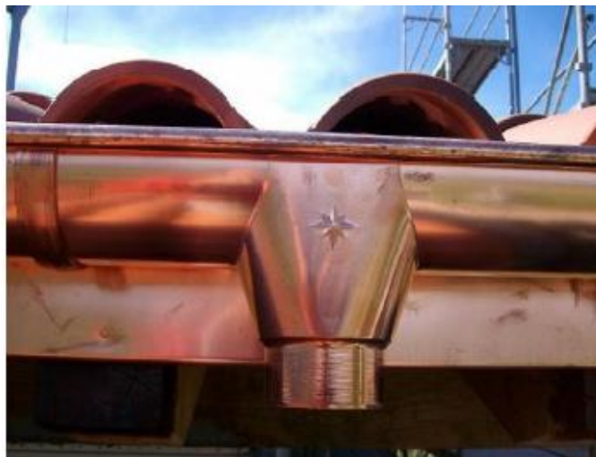
Figura 3.6 Canaleta de Cobre.
