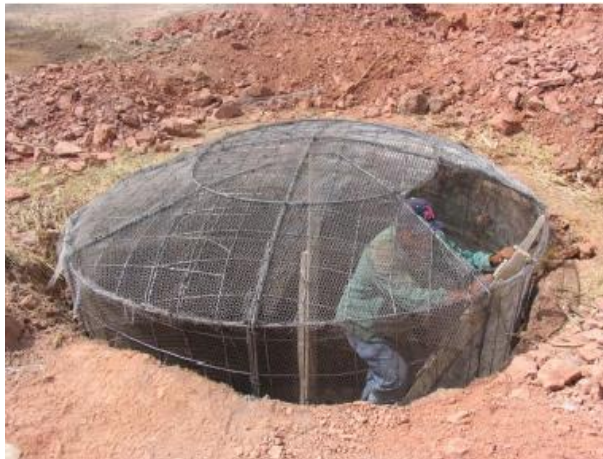
Figura 3. 10 Tanque de ferrocemento enterrado.
