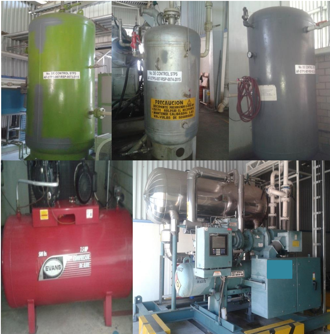
Imagen 3.2. Equipos sujetos a presión en la sección B
