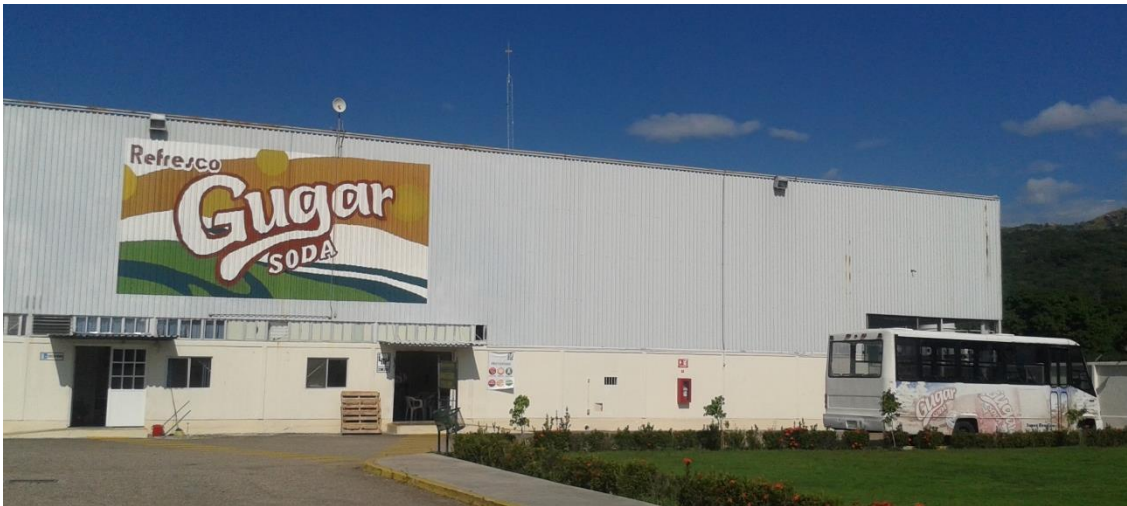
Imagen 1.1. Fachada principal de la planta Distribuidora Gugar S.A. DE C.V
