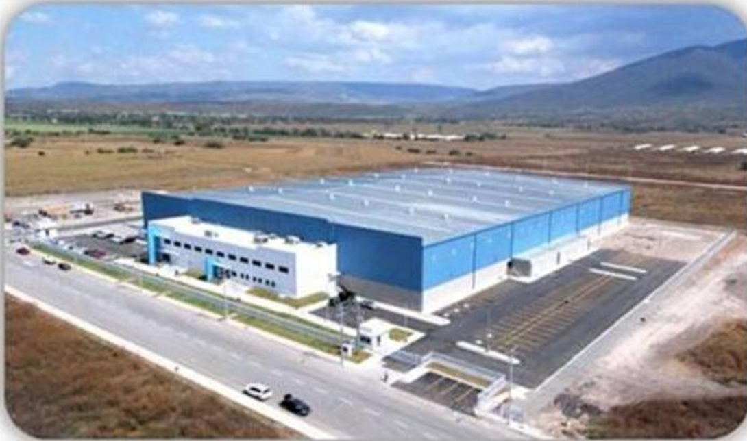
Figura 2.2 Foto panorámica de planta ACM
