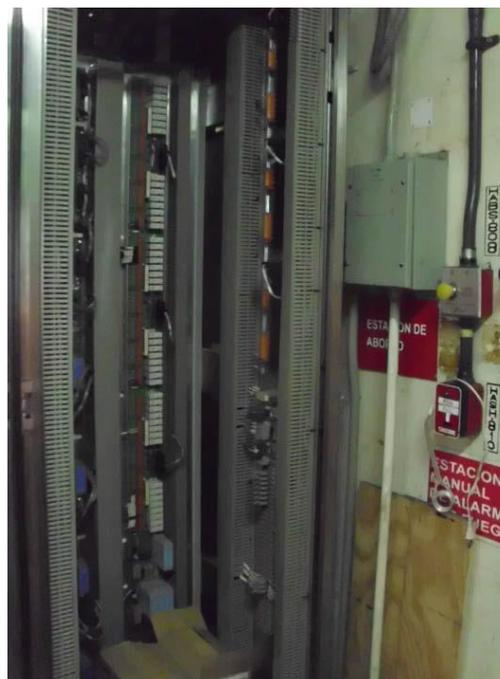
Figura 6.6 Gabinete NA2-SCD-UPR-002, aquí están instaladas las FTA para las conexiones a campo.
