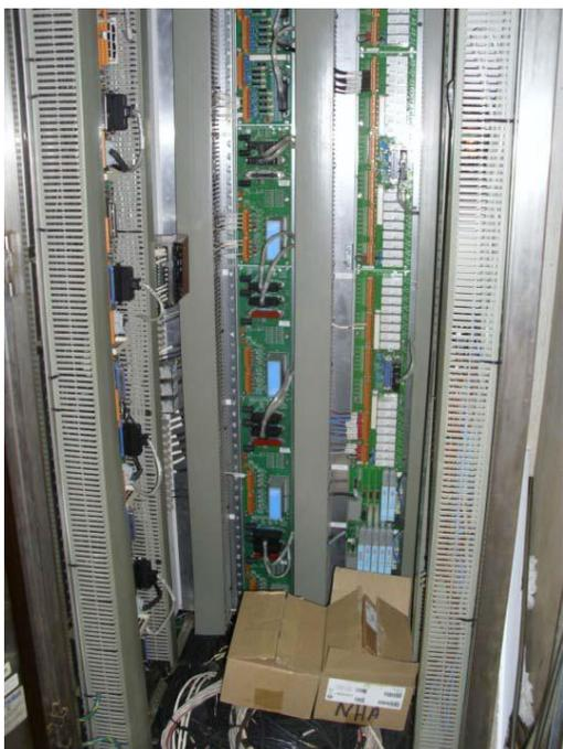
Figura 6.5 Gabinete NA2-SCD-UPR-002, aquí están instaladas las FTA para las conexiones a campo.
