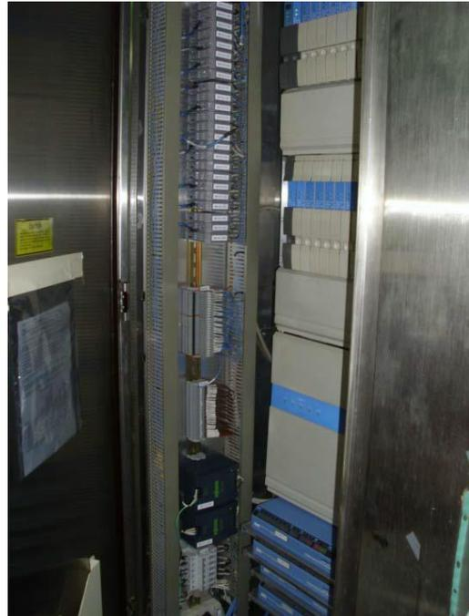
Figura 6.4 Interior del Gabinete NA2-SCD-UPR-001, HPM y Módulos IOP'S.
