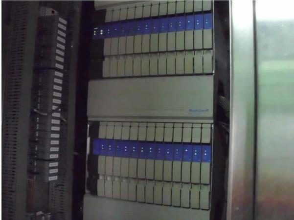
Figura 6.1 Se observa que no existe el HPM redundante en el fichero 1 del Gabinete NA2-SCD-UPR-001
