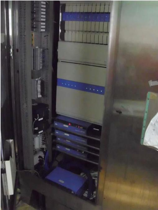
Figura 6.3 Interior del Gabinete NA2-SCD-UPR-001, HPM y Módulos IOP'S.
