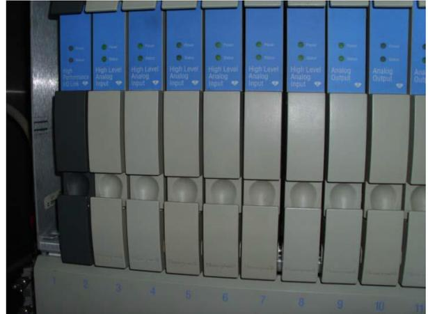
Figura 6.2 Existe un hueco donde debería ir el Procesador Redundante
