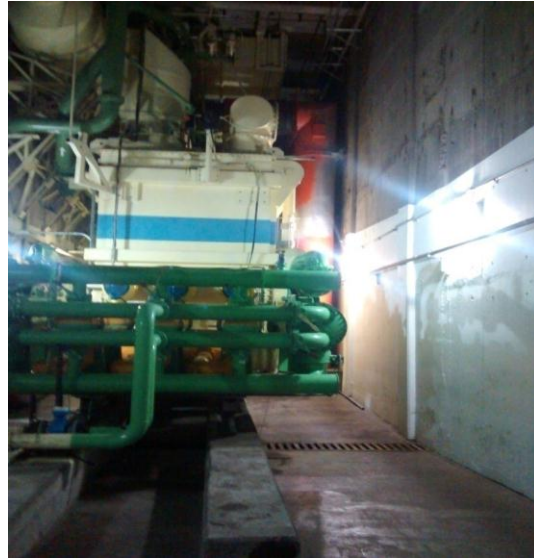
Figura 3.6 Foto de un transformador de caverna
