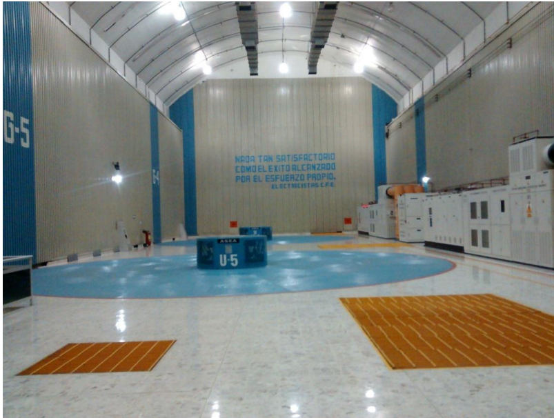
Figura 3.8 Foto de la playa de montaje de la casa de máquinas
