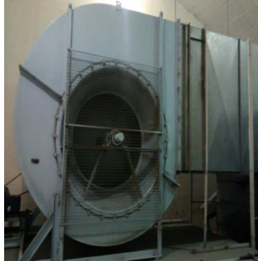
Figura 1.4 Inyectores de aire en los nichos de ventilación de la primera etapa de la casa de maquinas
