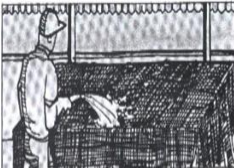
Figura 11. Curado de bloques con adición de agua. Fuente [19].
