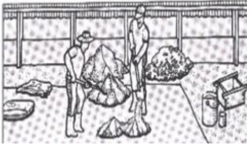
Figura 5. Dosificación de la arena y cemento. Fuente [12].
