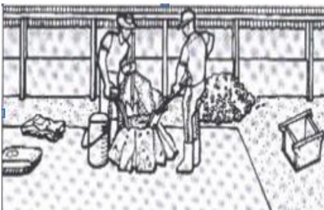
Figura 6. Adición del agua a la mezcla. Fuente [13].
