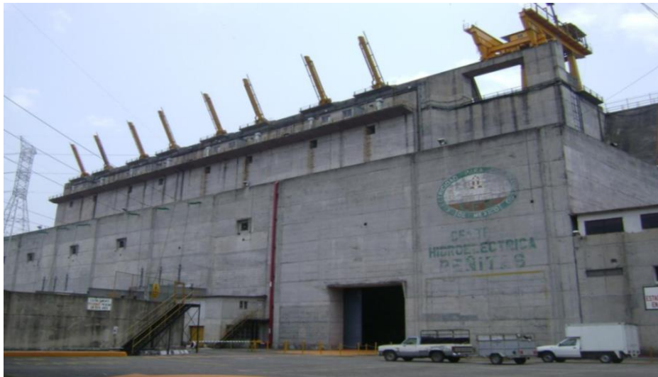
Figura 1. 1 Casa de máquinas de la C.H. Ángel Albino corzo.
