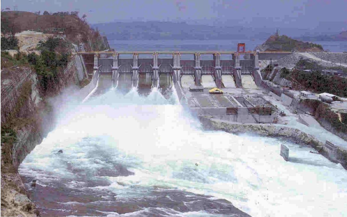
Figura 1. 6 Vertedor de demasías
