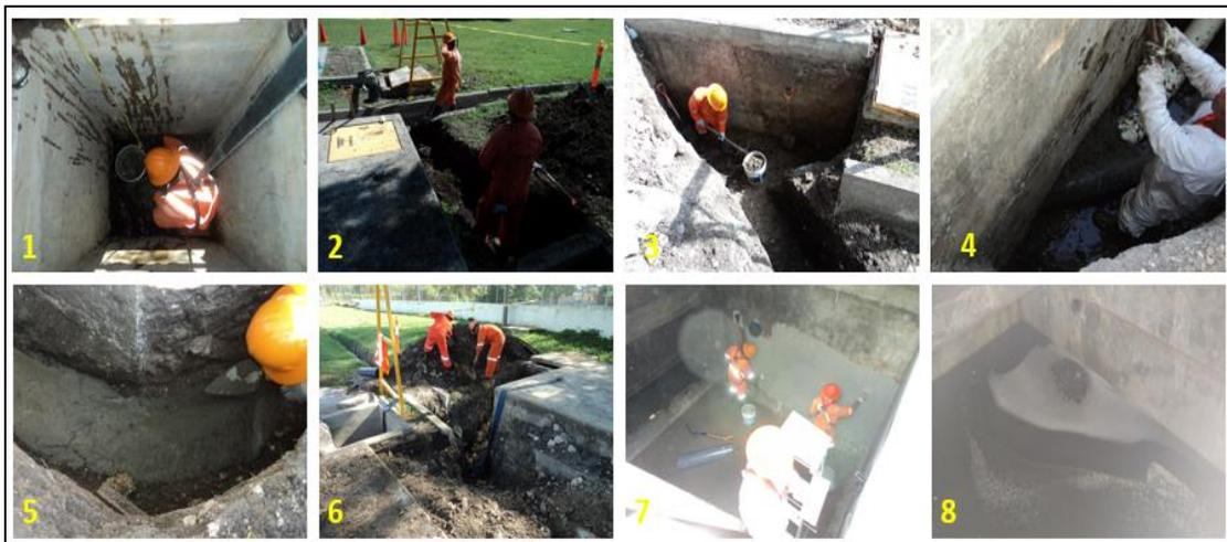
**Figura 23. Procedimiento para el mantenimiento, reubicación y habilitación de los registros y de la cisterna**
