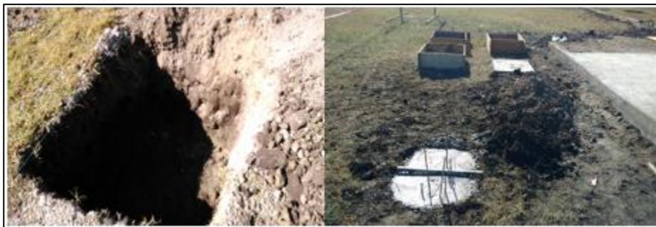
**Figura 36. Antes y después de la colocación de la zapata para la estructura.**
