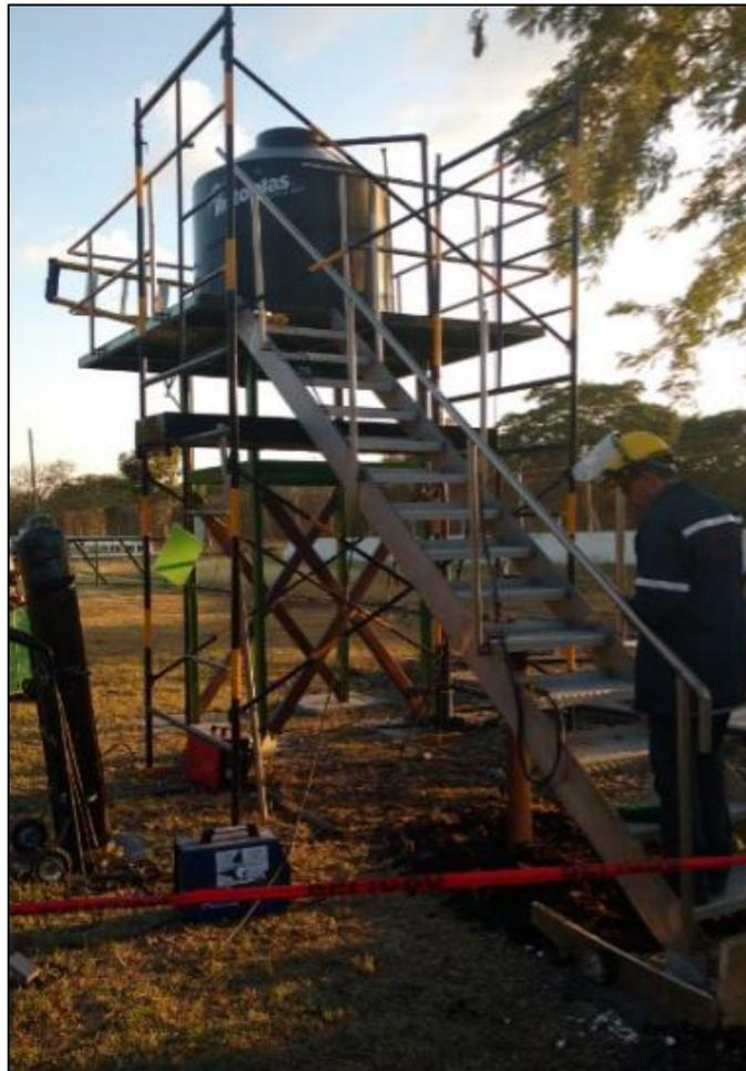
**Figura 38. Colocación y fijación de la escalera para el acceso al tinaco.**
