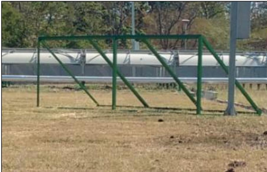
**Figura 39. Estructura de los paneles solares, cuenta con una inclinación de 40°**
