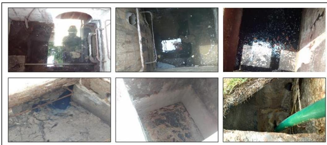
**Figura 19. Registros RAP 78, RAP 104, RAP 150, RAP 191, RAI 190 y RAI 202 respectivamente, son los registros causantes de la contaminación de agua pluvial con industrial y del bloqueo del flujo de agua en sus respectivas líneas**
