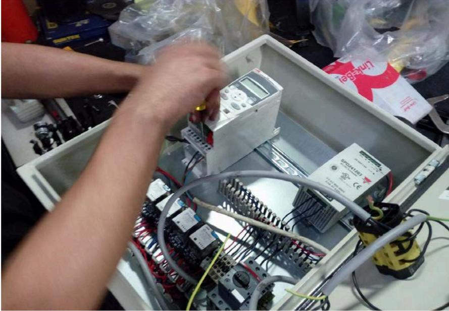
Fig. 71 Gabinete de control del variador de velocidad para el motor.
