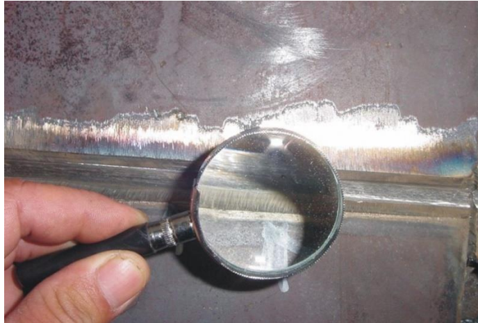
Figura 3.7 Inspección visual a soldadura apoyado por una lupa.
