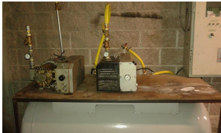
Figura 26 Instalación de una segunda bomba
