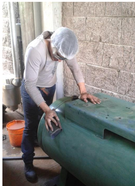
Figura 31 Mantenimiento al pulmón principal
