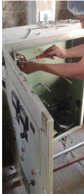
Figura 30 Limpieza de panel para el control
