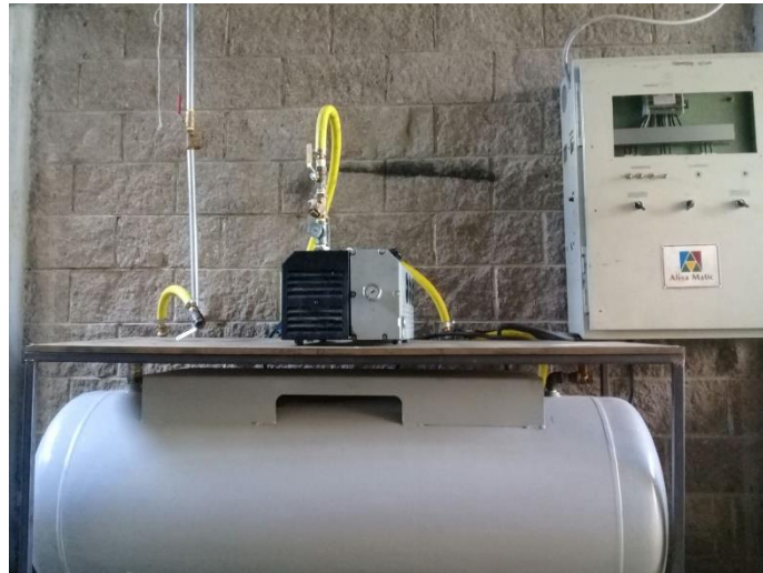
Figura 25 Pruebas iniciales de funcionamiento
