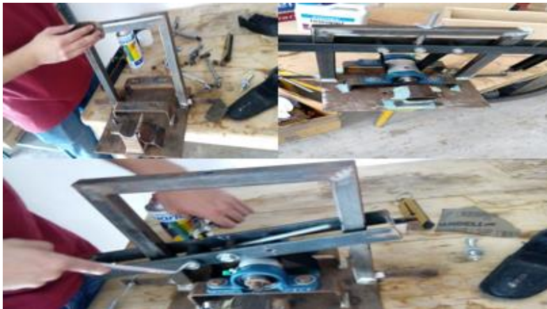
Ilustración 35 lijado y resanado de la estructura metálica.
