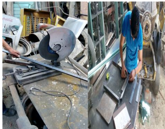
Ilustración 25 corte y soldadura del marco base tensor.
