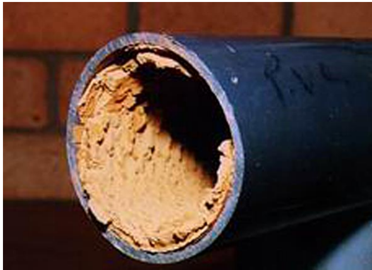
Imagen 2.1. Acumulación de carbonato cálcico en el interior de una tubería. “Tubería calcio” by Josefus2003 – Own work. Licensed under CC BY 3.0 via Wikimedia Commons.
