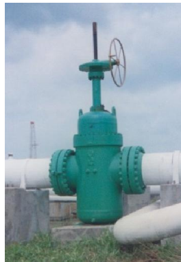
Fig. 14 Válvula de compuerta
