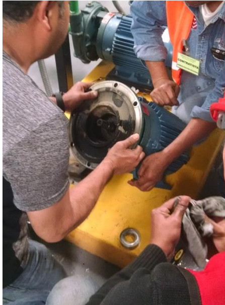
(12) Cambio de rodamientos y sello mecánicos.
