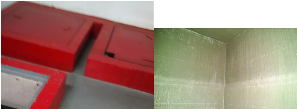
(7) Cisternas en buen estado y cerradas.
