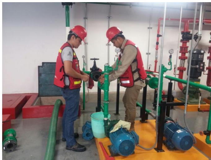
(8) Verificación de elementos de tubería
