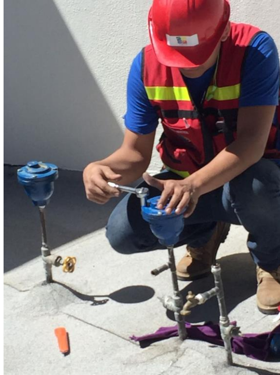
(9) Mantenimiento a válvulas expulsoras de aire.
