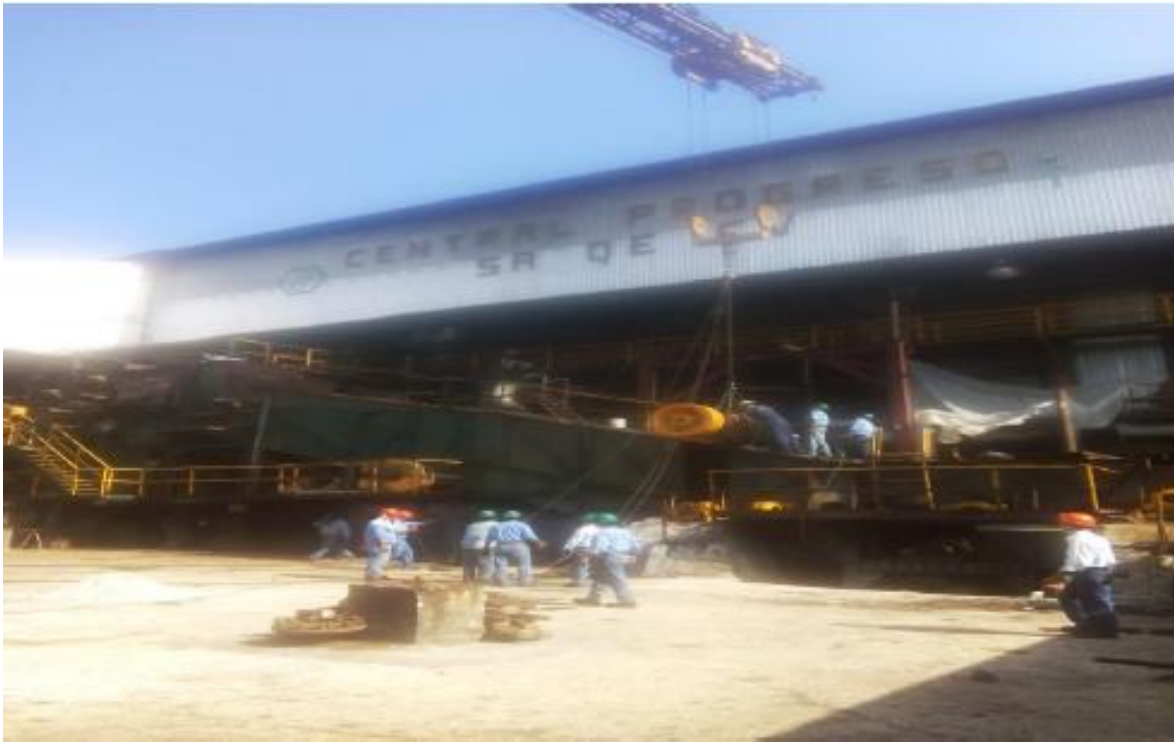
Fig. 1.2 Foto actual del ingenio central progreso S.A de C.V
