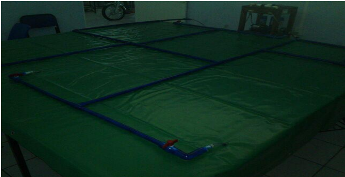
Fig.3.1.8 Acabado final de la red hidráulica
