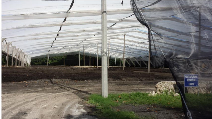
Figura 13. Plataforma de secado de lodos.
