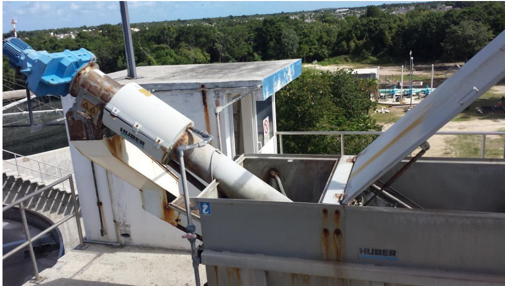
Figura 5. Maquina Huber de separador de sólidos.
