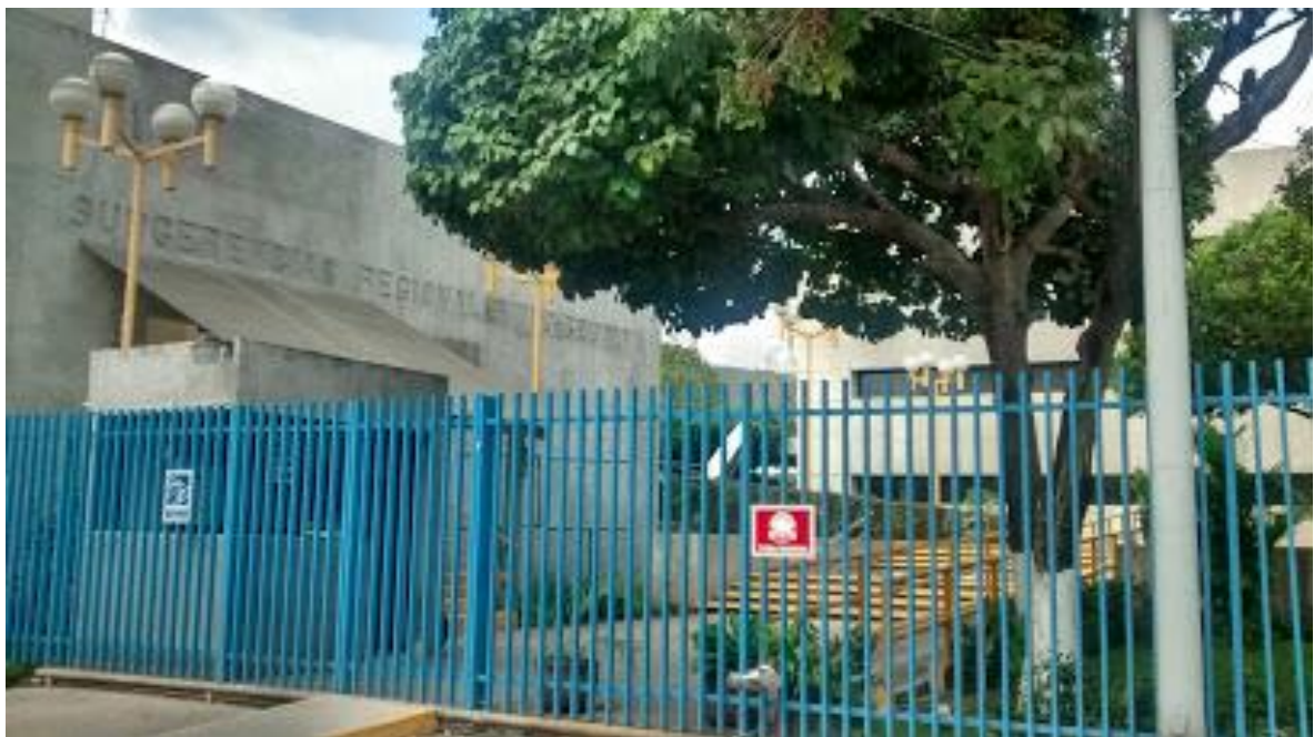
Imagen 1: fotografía de la Subgerencia Regional Hidroeléctrica Grijalva.
