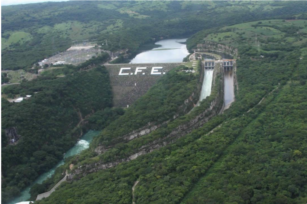
Imagen 4: Central Hidroeléctrica Angostura.
