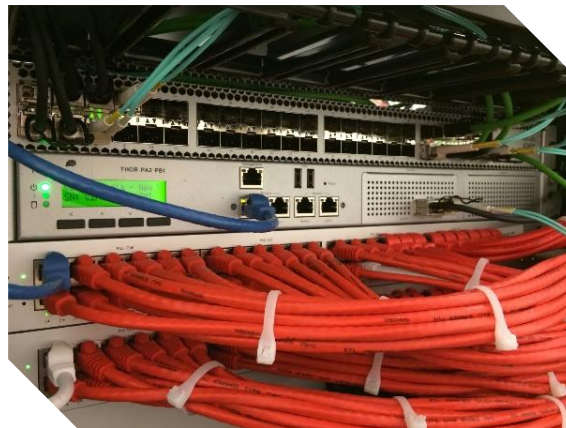
Ilustración 17. Ruteo de cables
